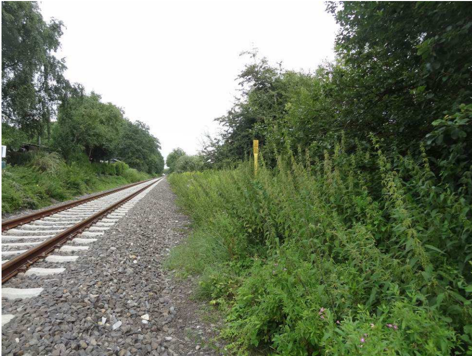
Abb. 2: Typisches Bild des Neuverlegungsabschnitts in gleicher Trasse
