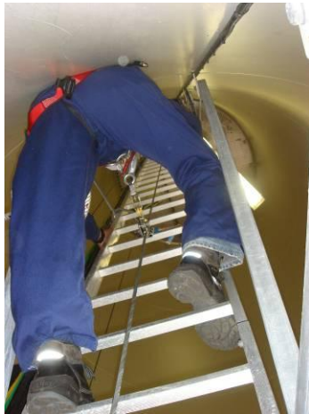
Bild 7 19: Steigen Sie auf die andere Seite der Leiter, und befestigen Sie die Fallsicherung an der starren Verankerungsleine.
