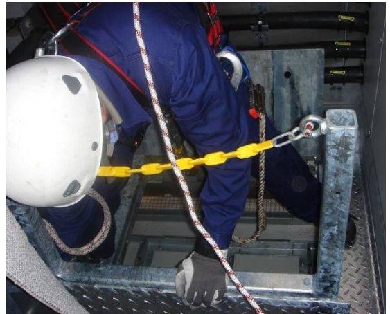
Bild 7 2: Öffnen Sie die Notausstiegsluken in der Gondel.
