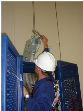
Bild 7 15: Befestigen Sie den Haken an einem sicheren Verankerungspunkt.
