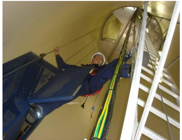
Bild 7 17: Ergreifen Sie die Leiter mit einer Hand, und schwingen Sie das andere Bein zur Vorderseite der Leiter.
