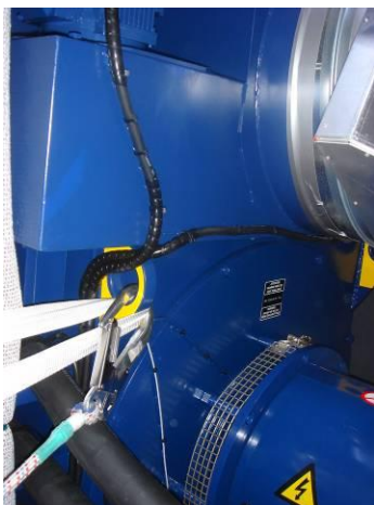
Bild 7 7: Legen Sie die entsprechende Fallsicherungsausrüstung zur Sicherung an, und befestigen Sie diese an dem dafür vorgesehenen Verankerungspunkt in der Nähe des Notausgangs.
