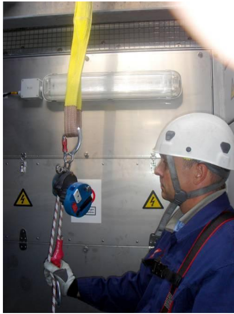
Bild 7 3: Befestigen Sie die Abseilausrüstung für Notfälle an einem dafür vorgesehenen Verankerungspunkt.
