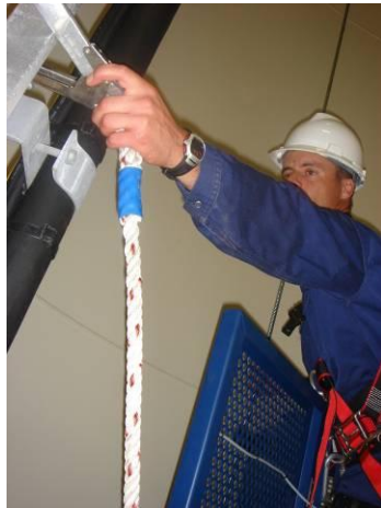
Bild 7 16: Befestigen Sie den Karabinerhaken des Positionierungsseils um die Leiterholme.
