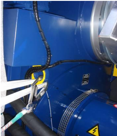
Bild 7 1: Legen Sie die entsprechende Fallsicherungsausrüstung zur Sicherung an, und befestigen Sie diese an dem dafür vorgesehenen Verankerungspunkt in der Nähe des Notausgangs.
