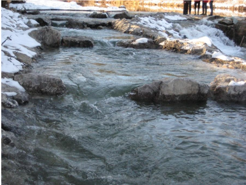
Abbildung 1: Raugerinnebeckenpass an der Loisach in Oberbayern (Foto: RMD CONSULT)
