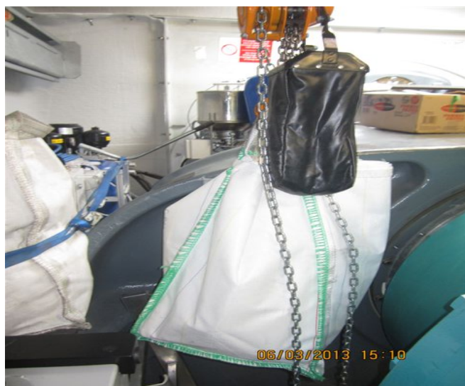
Abbildung 6: Materialhub in das Maschinenhaus mit Kettenzug
