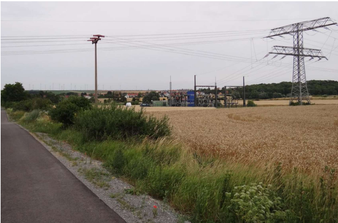
Abbildung 54: Umspannwerk und kV-Leitung südlich von Tonna
