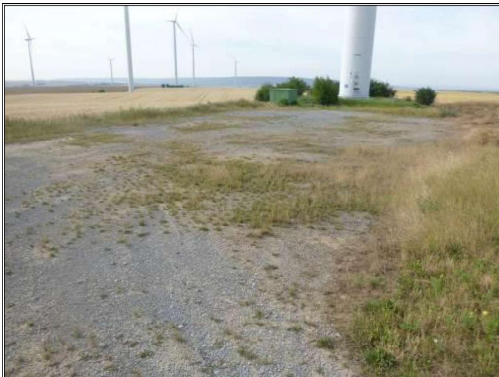
Abbildung 27: Schotterauflage vor den bestehenden Windkraftanlagen, mit bereits errichtetem Windpark im Hintergrund
