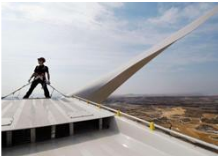
Abbildung 9-1: Arbeiten auf dem Maschinenhaus
