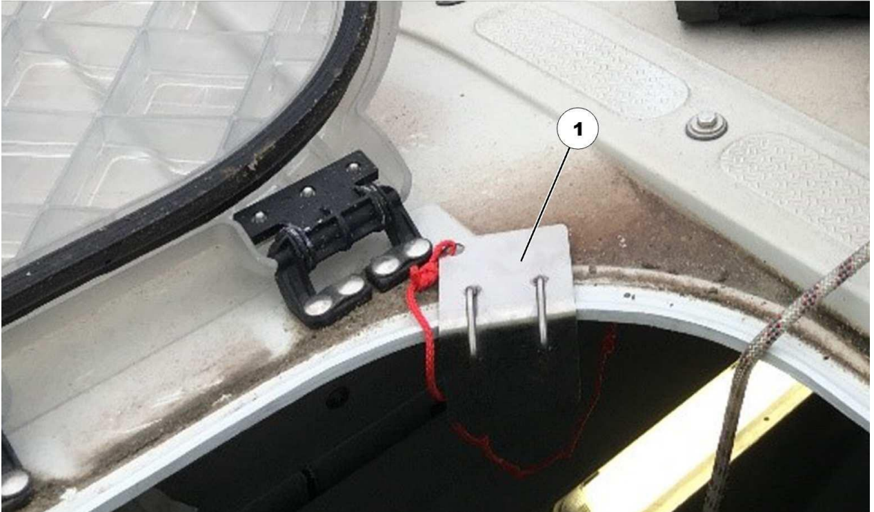
Abbildung 5.15: Kantenschutzvorrichtung am Rand der Dachluke
