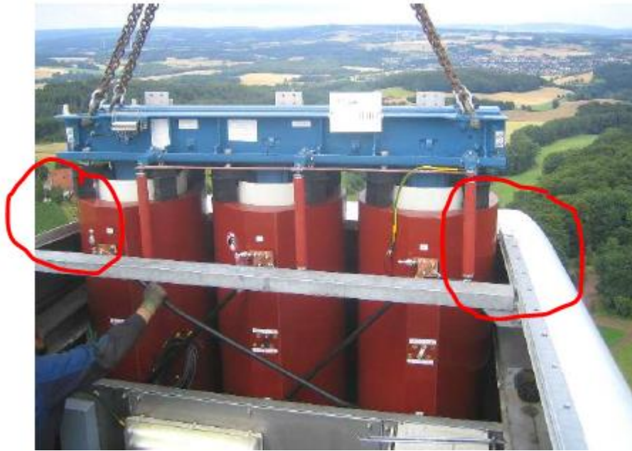
Abbildung 17-1: Führen des Transformators in das Maschinenhaus
