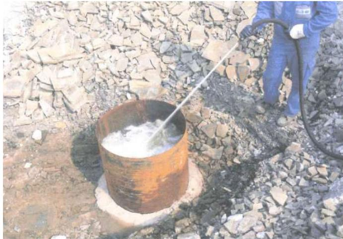
**Abbildung 16: Befüllen des eingebauten Rohres (aus [6])**
