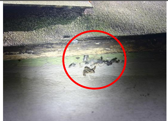
Quartier Nr. G2, Kot unter Dachpappe
