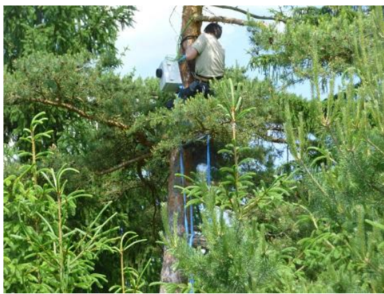
Befestigung der Dauerbox mittels Klettertechnik am Standort 2 in Treppendorf
