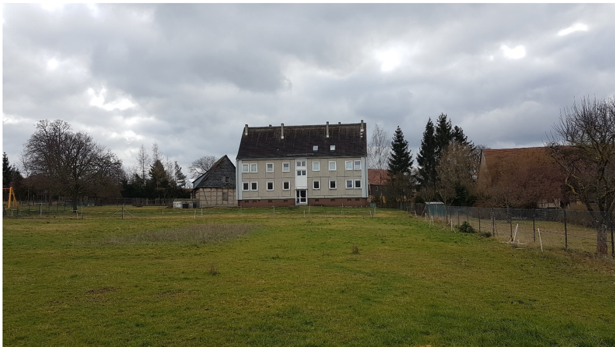
Foto F28: Treppendorf, IO T (dem Windpark zugewandte Seite)
