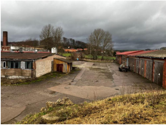
Abbildung 13 Blick Richtung Nordosten mit Sicht auf Stallanlage (links) und Werkstatt (rechts), Foto W+G, 5.1.2023.
