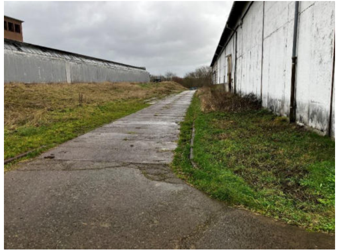
Abbildung 8 Blick Richtung Südosten, zu erhaltender Fahrweg zwischen Lagerhalle und Stallanlage, Foto W+G, 5.1.2023.
