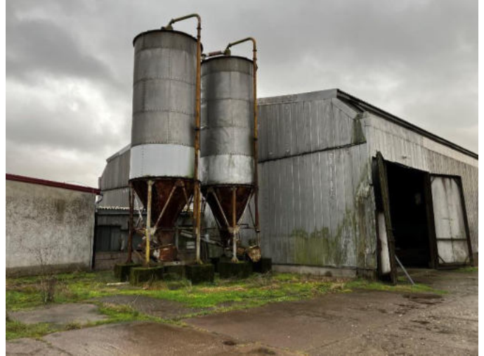
Abbildung 2 Blick Richtung Süden mit Ansicht Bergeraum, Foto W+G, 5.1.2023.
