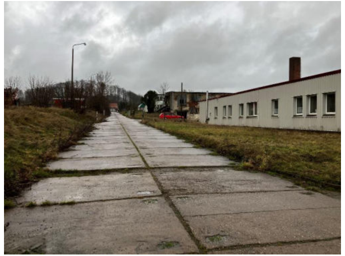
Abbildung 14 Blick Richtung Nordosten mit Sicht auf die übliche Flächenbefestigung aus Betonplatten und Sicht auf Verwaltungsgebäude (rechts), Foto W+G, 5.1.2023.
