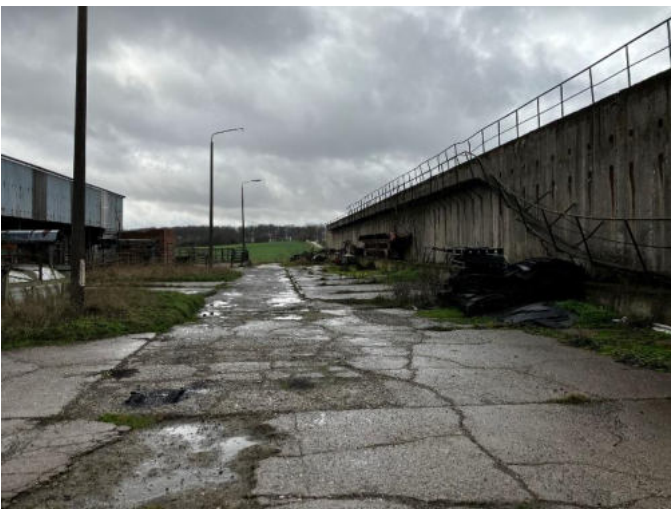
Abbildung 5 Blick Richtung Südwesten mit Ansicht der offenen Silolager (rechts) und Stallanlagen (links), Foto W+G, 5.1.2023.
