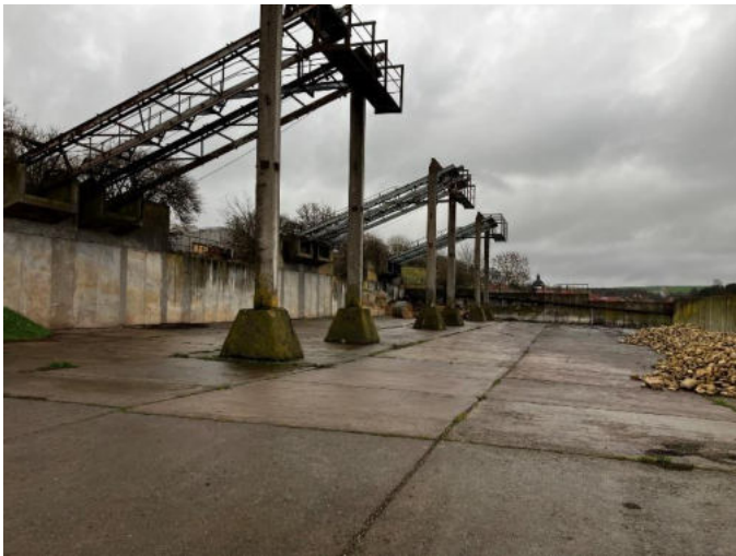
Abbildung 9 Ansicht Düngelege im Südosten des Plangebietes, Foto W+G, 5.1.2023.
