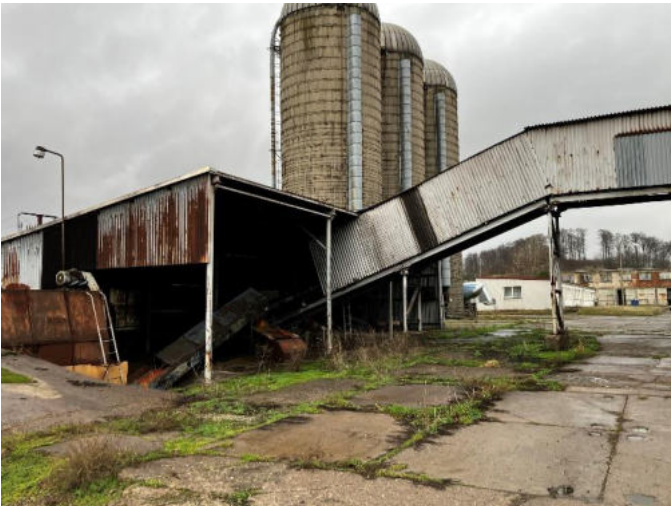
Abbildung 3 Blick Richtung Westen mit Ansicht Silos und Fütterungsanlage, Foto W+G, 5.1.2023.
