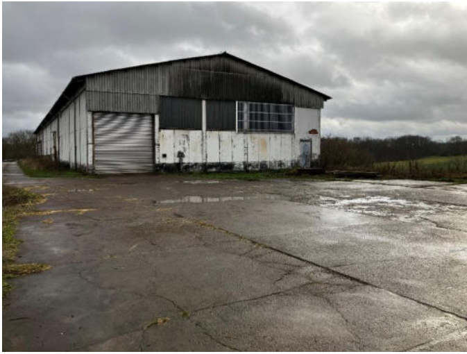
Abbildung 7 Blick Richtung Südosten mit Ansicht der zu erhaltenden Lagerhalle mit Vorplatz, Foto W+G, 5.1.2023.
