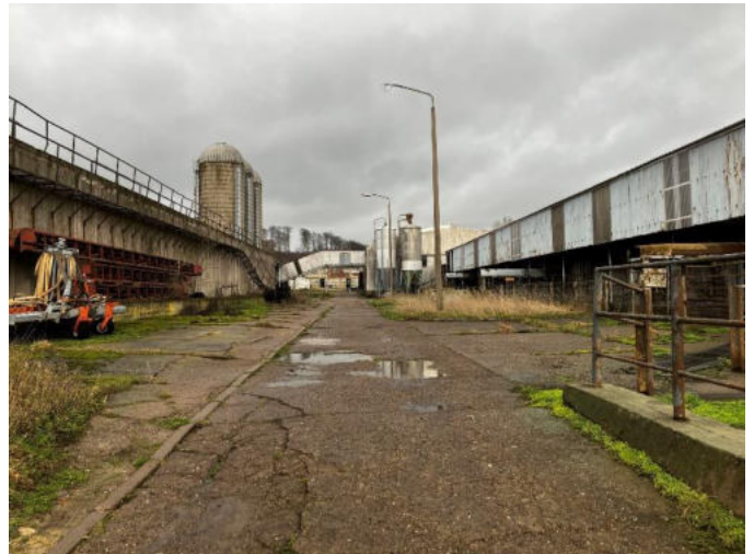
Abbildung 4 Blick Richtung Nordosten mit Ansicht Silos (links) und Stallanlagen (rechts), Foto W+G, 5.1.2023.
