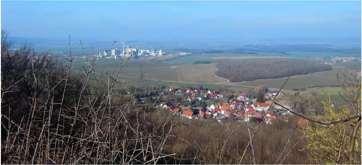
Abb. 34: Blick vom Rondel aus in nordwestliche Richtung; i.V. Siedlungsbereich Vollenborn und i.H. Industrieanlage des Zementwerkes
