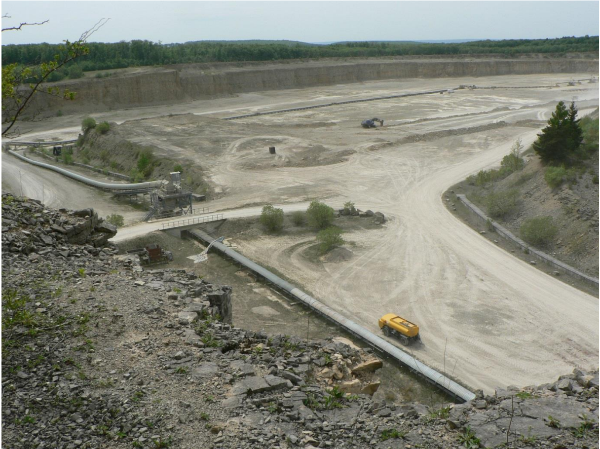
Abb. 36: Förderanlagen zum Transport des Kalksteins in Vorratssilos des Zementwerkes
