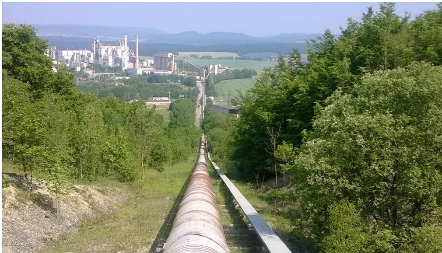
Abb. 7: Gurtbandförderer für den Materialtransport (Kalkstein) zum Zementwerk
