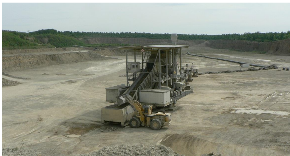
Abb. 6: Beschickung der Brecheranlage durch Radlader; im Hintergrund: Förderanlagen
