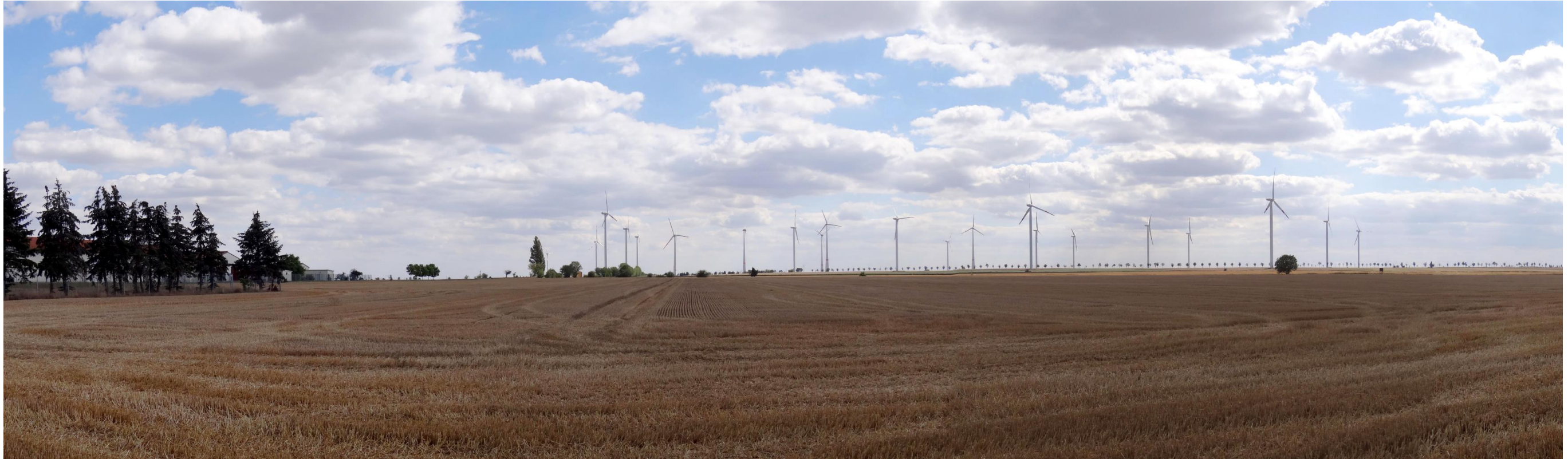
Abbildung 9: FP1 Blick von Üllnitz in Richtung Süden auf bestehenden Windpark
