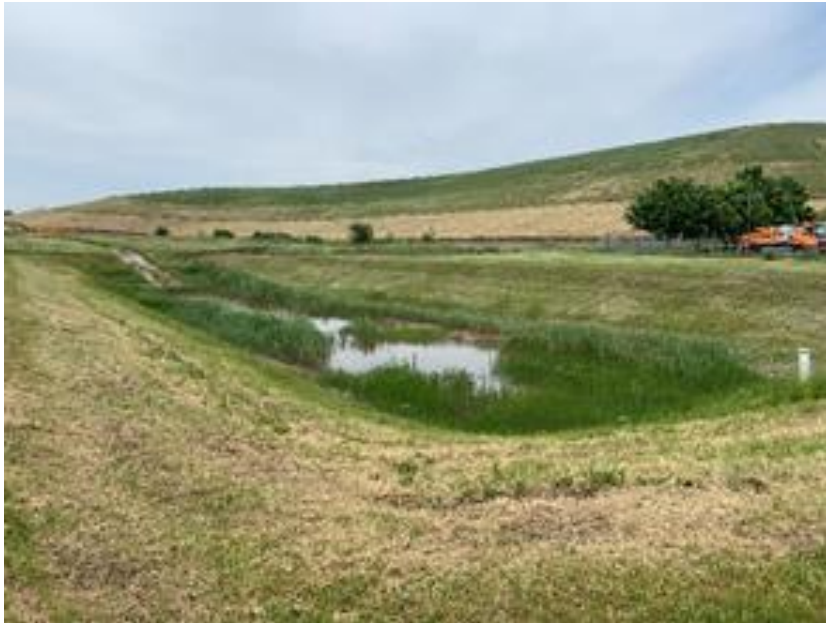
Abb. 9: Absetzbecken mit Wasserfläche (Foto IHU Juni 2021)
