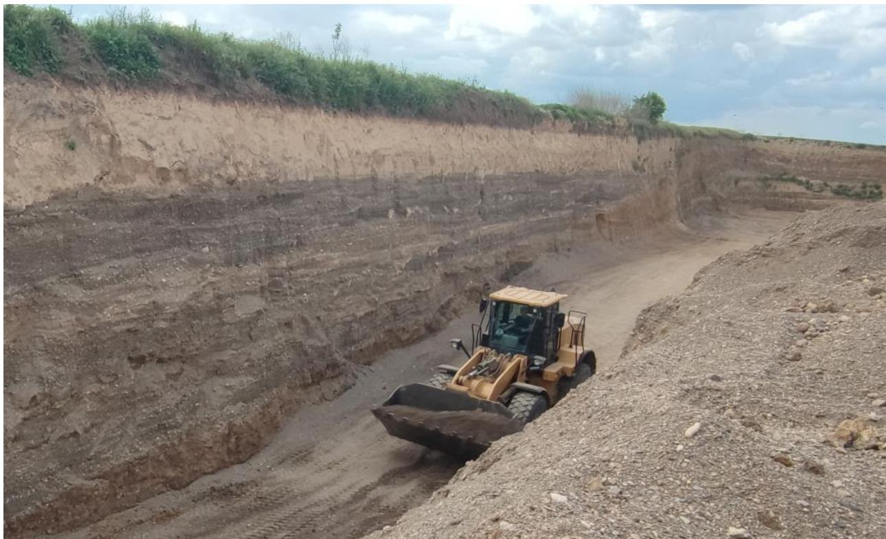
Abbildung 3-1: Nördliche Tagebauböschung mit Löß und Mutterbodenüberdeckung
