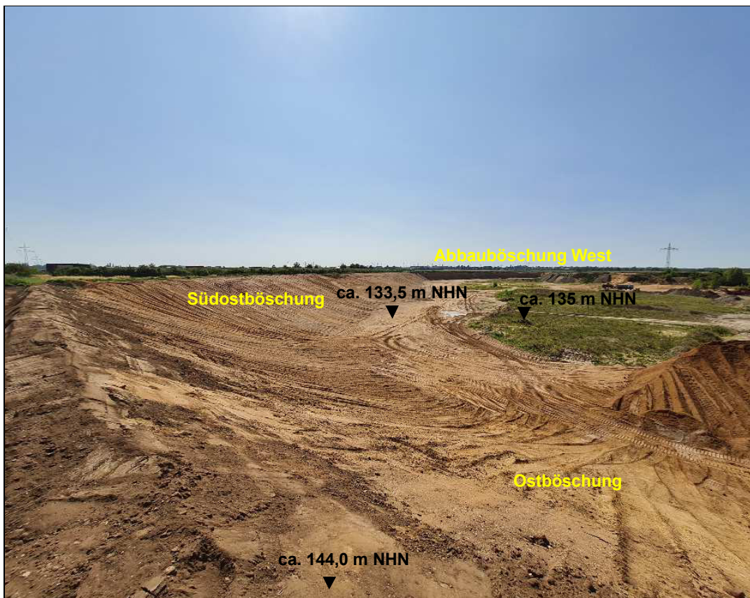
Fotostandort Böschungsoberkante der östlichen profilierten Kiesböschung mit Blick nach Westen in Richtung des noch fertig zu profilierenden Deponieplanums
