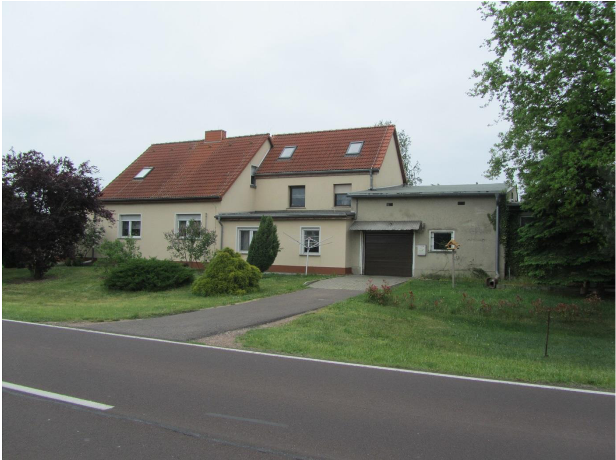
Abb. 7: IO 7a - Sicht auf Westfassade
