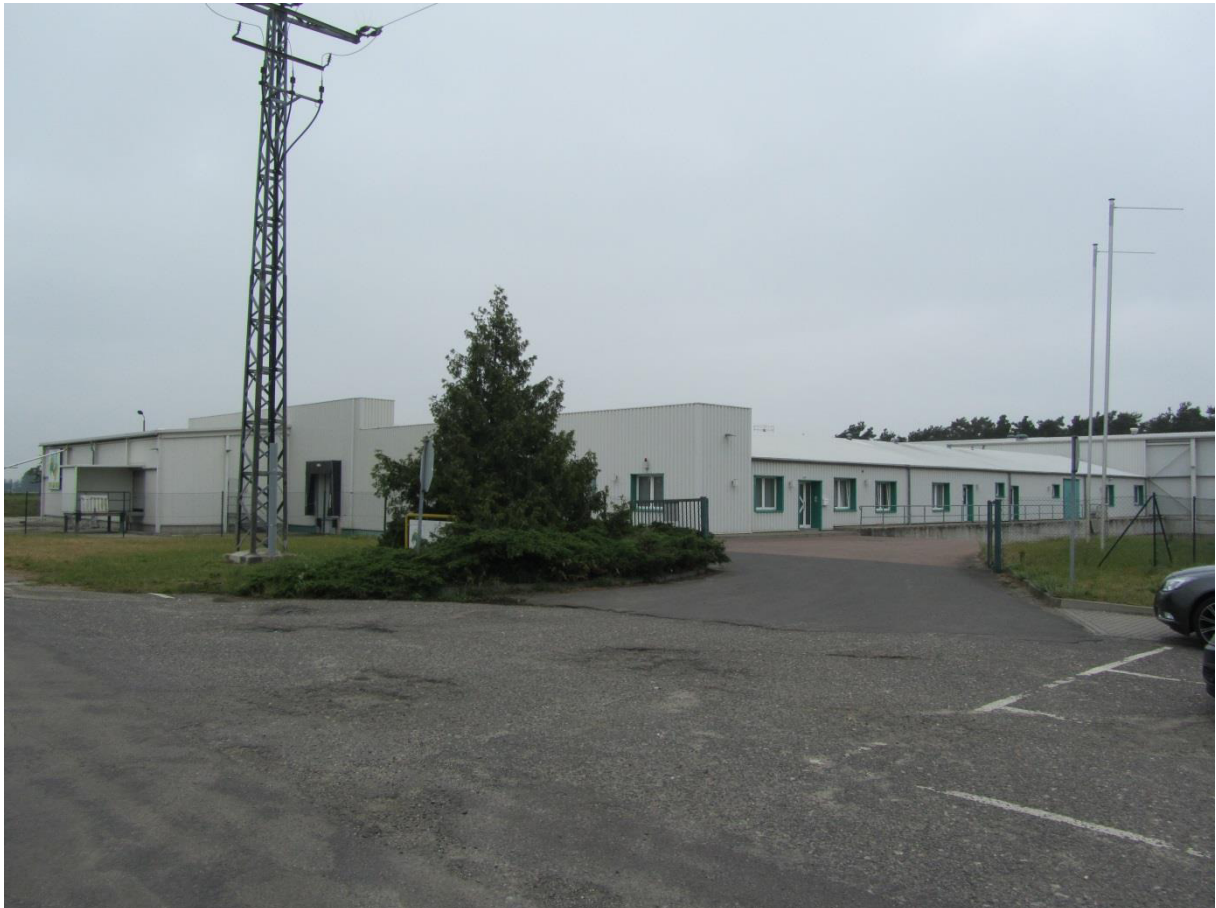
Abb. 5: IO 5 - Sicht auf Süd- und Ostfassade
