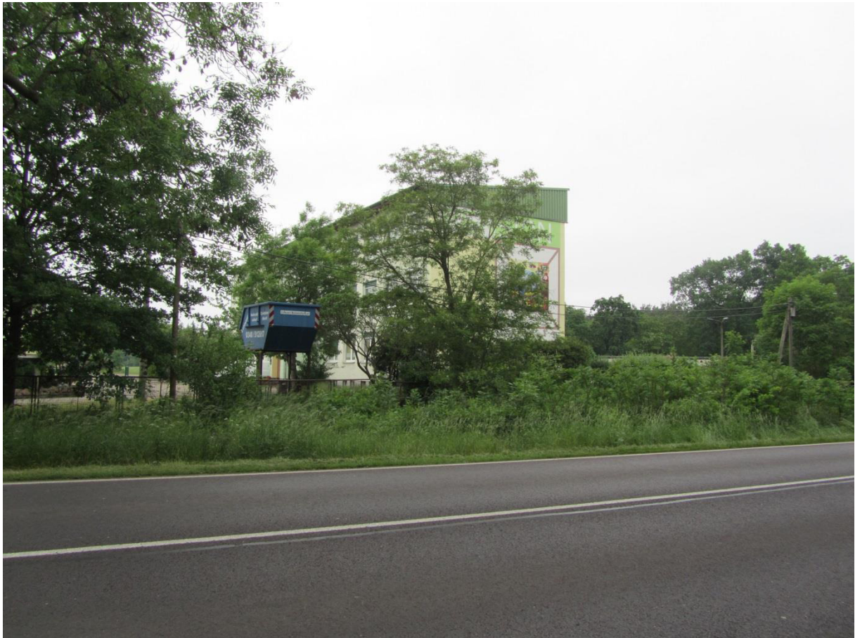
Abb. 2: IO 2 - Sicht auf Süd- und Westfassade
