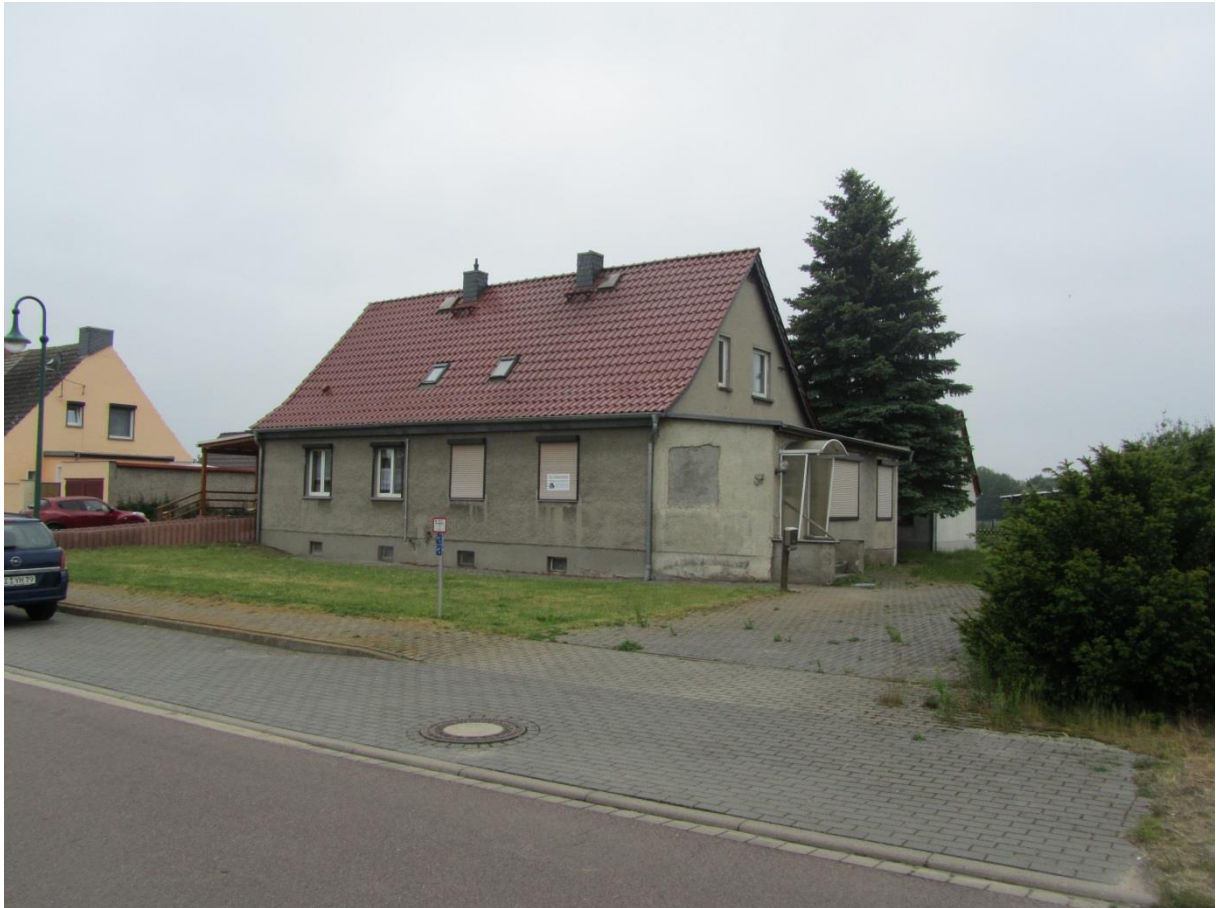
Abb. 14: IO 11b – Sicht auf Nord- und Ostfassade
