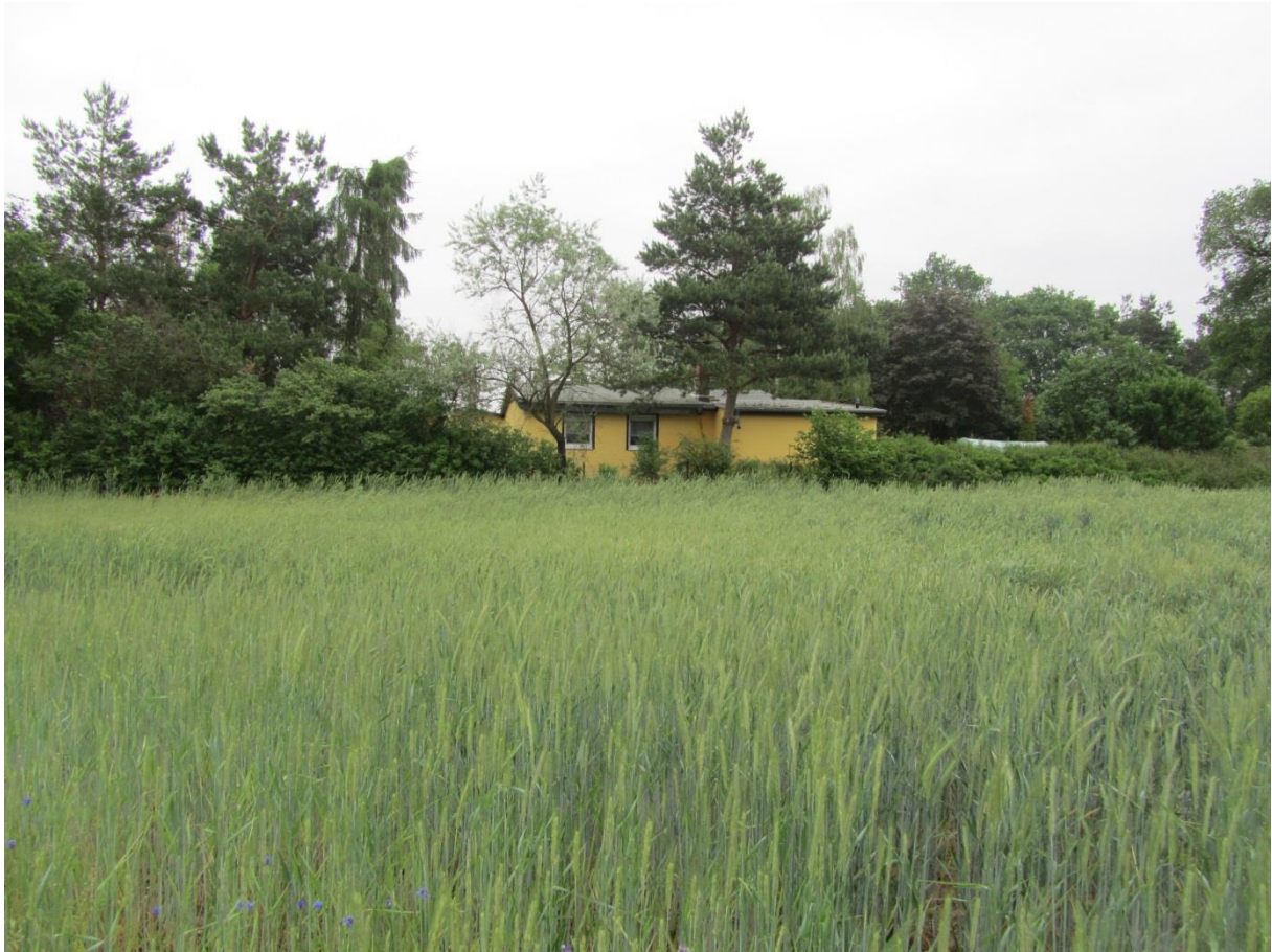
Abb. 8: I0 7b - Sicht auf Westfassade
