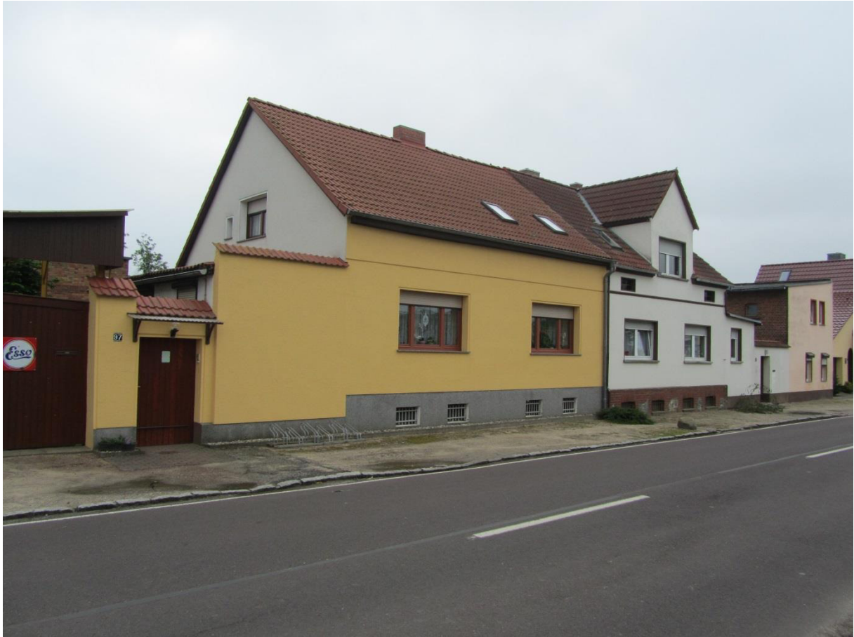
Abb. 11: IO 9b - Sicht auf Nordfassade
