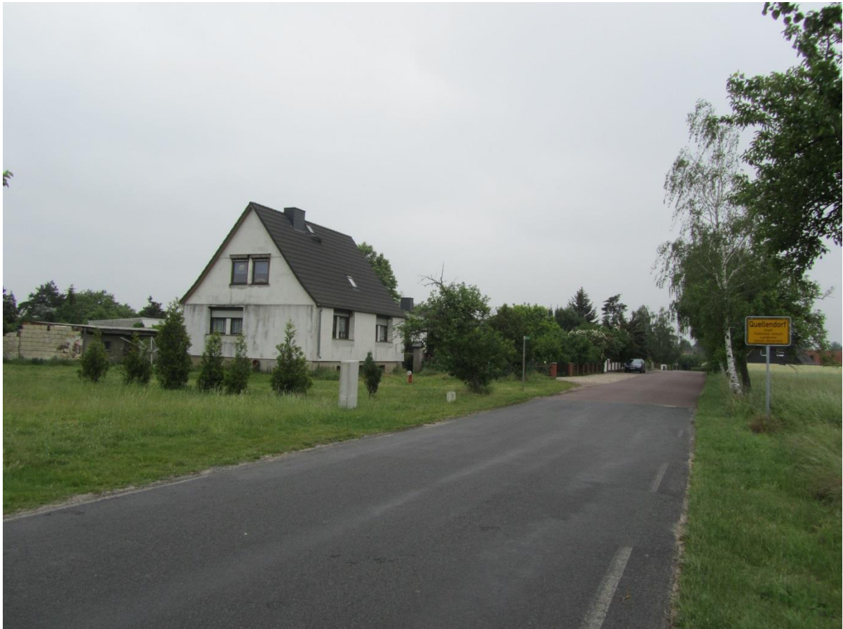
Abb. 12: IO 10 - Sicht auf Nord- und Westfassade
