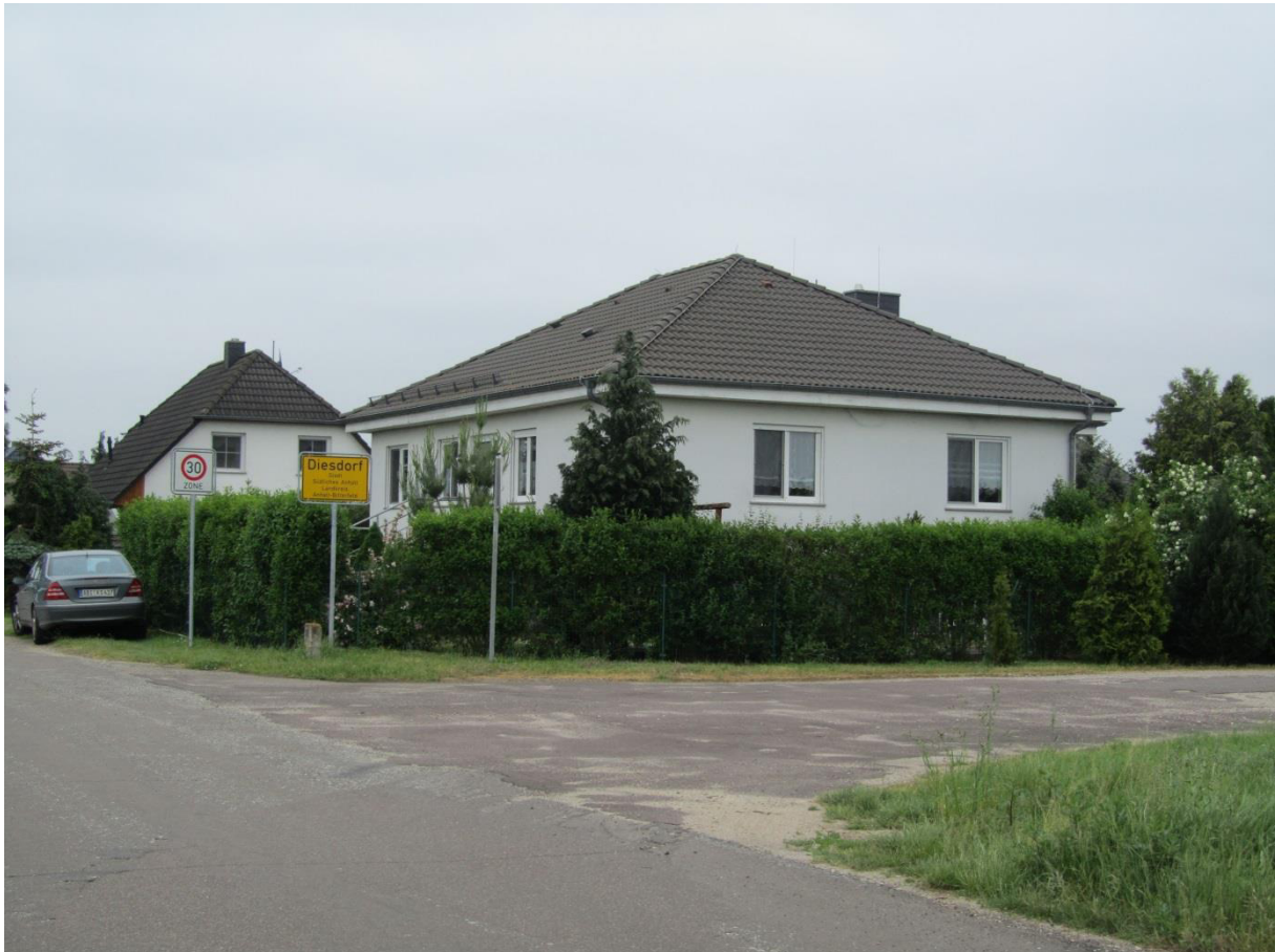
Abb. 9: IO 8 - Sicht auf Nord- und Westfassade
