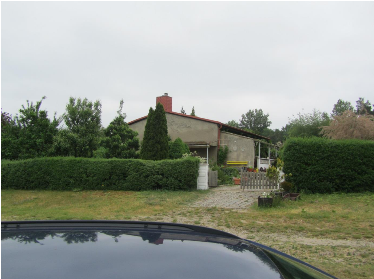
Abb. 4: IO 4 - Sicht auf Westfassade
