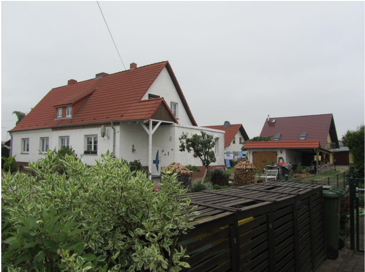
Abb 17: IO 13 - Sicht auf Süd- und Westfassade
