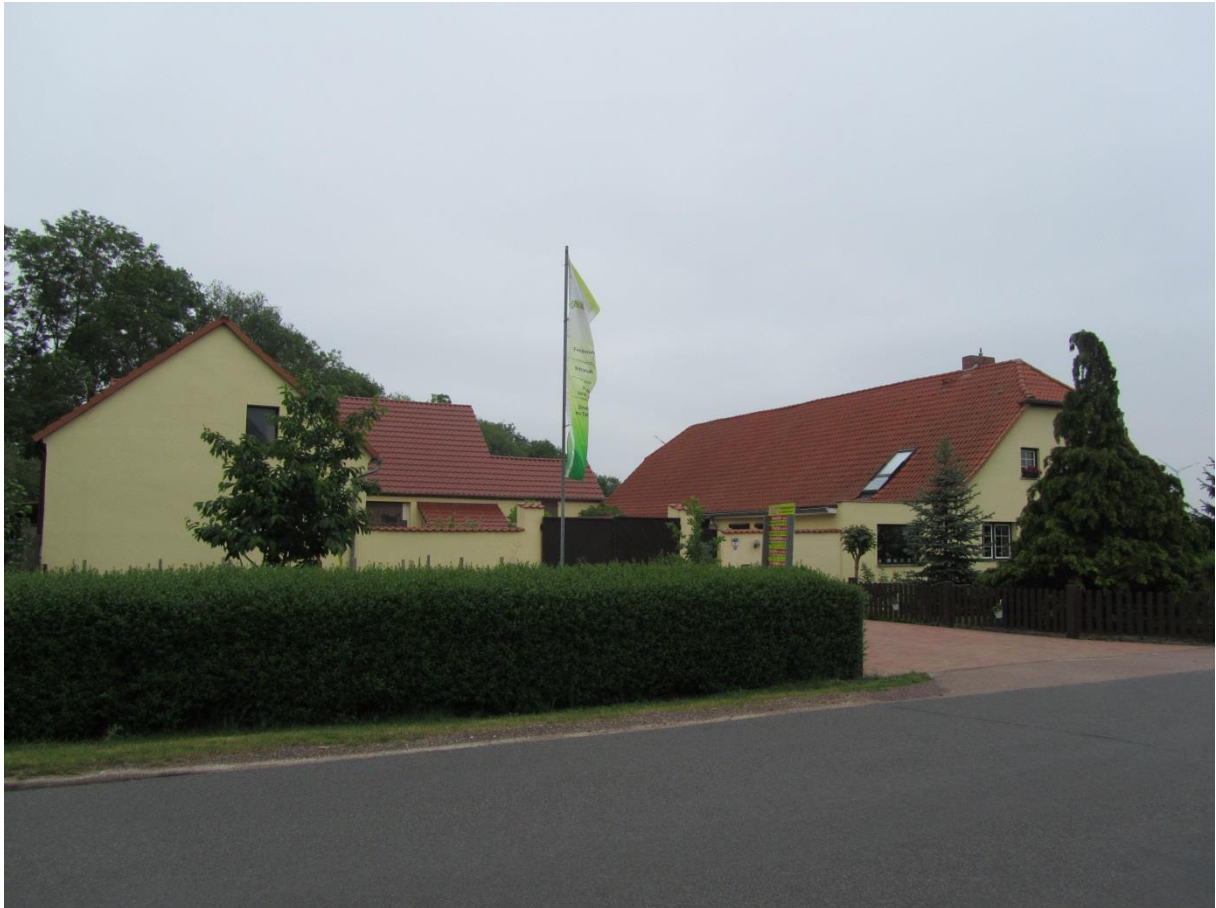
Abb. 18: IO 14 - Sicht auf Westfassade (es wird angenommen, dass Richtung Windpark Fenster vorhanden sind)
