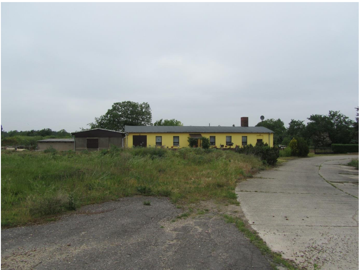
Abb. 1: IO 1 - Sicht auf Südfassade
