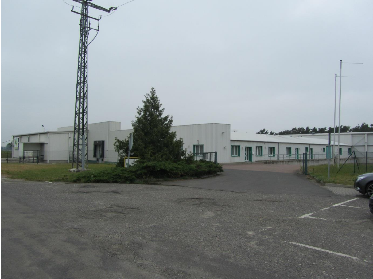
Abb. 5: IO 5 - Sicht auf Süd- und Ostfassade
