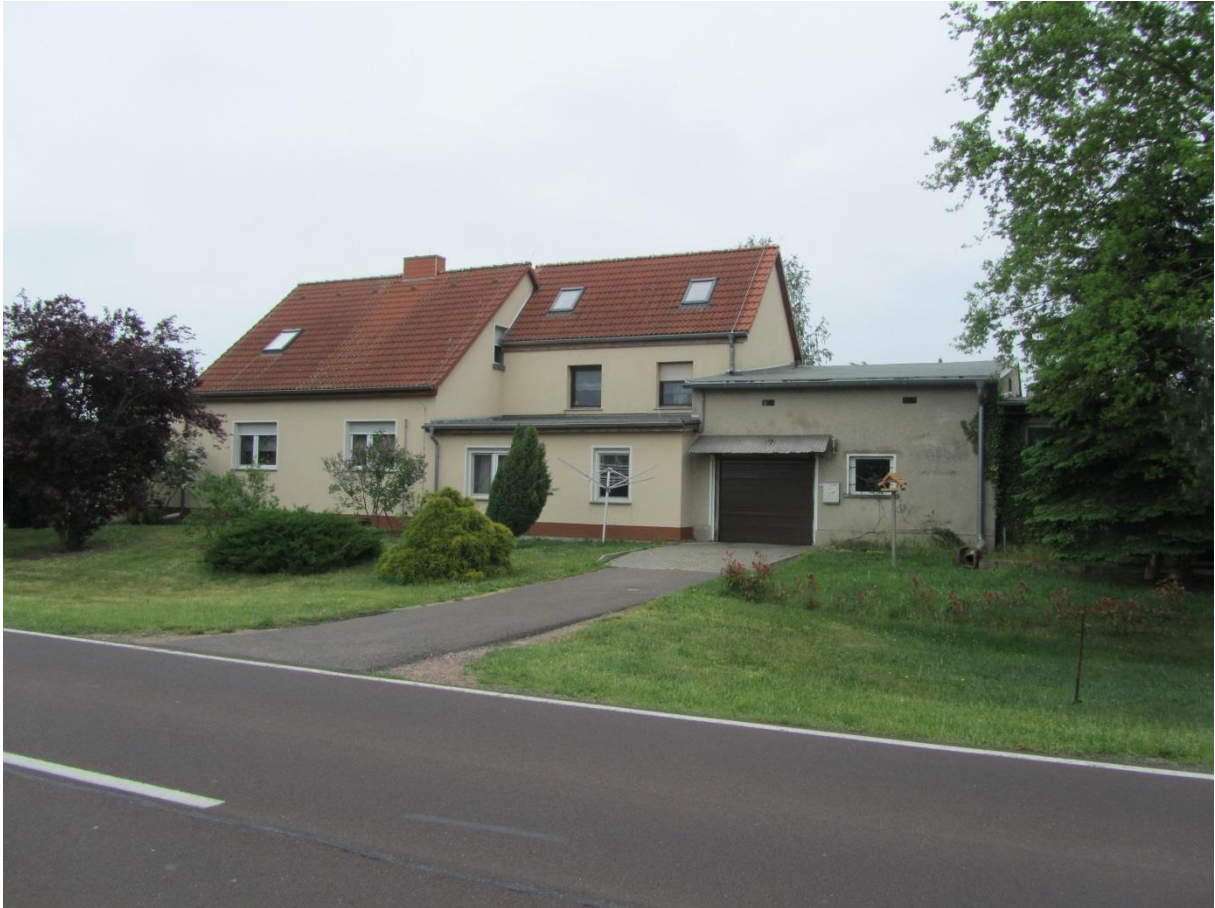
Abb. 7: IO 7a - Sicht auf Westfassade
