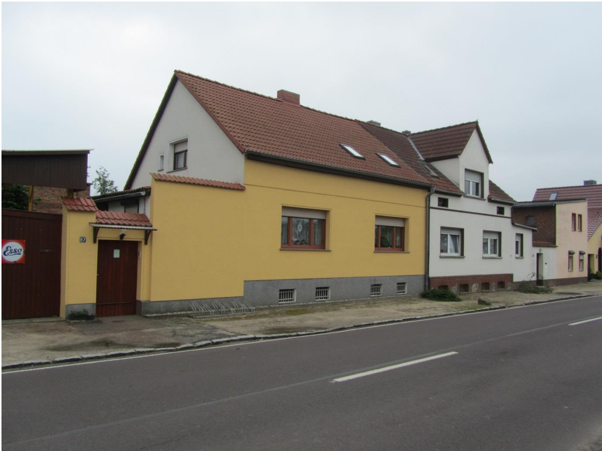
Abb. 11: IO 9b - Sicht auf Nordfassade
