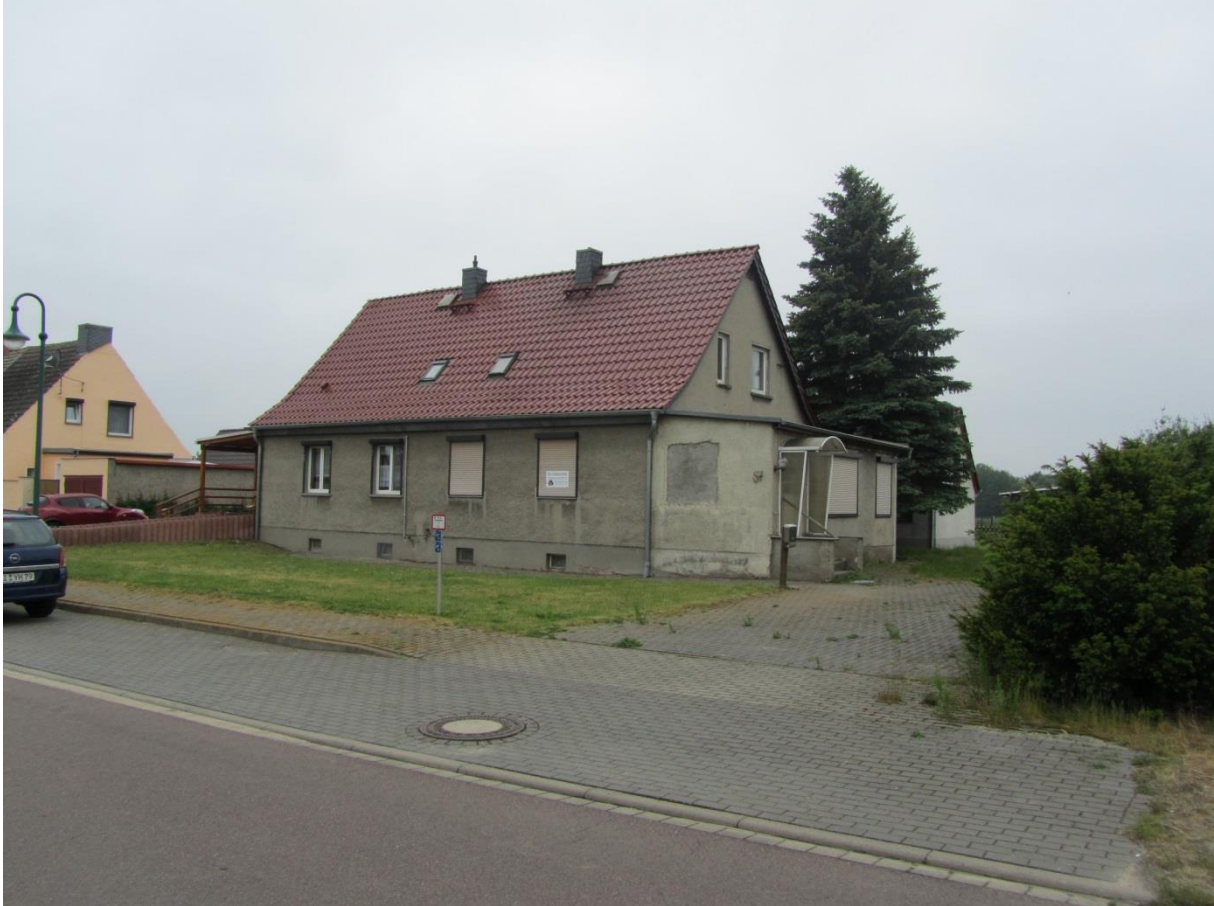
Abb. 14: IO 11b – Sicht auf Nord- und Ostfassade
