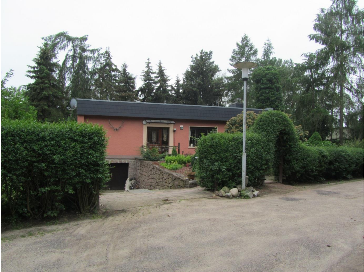
Abb. 3: IO 3 - Sicht auf Nordfassade (es wird angenommen, dass Richtung Windpark Fenster vorhanden sind)
