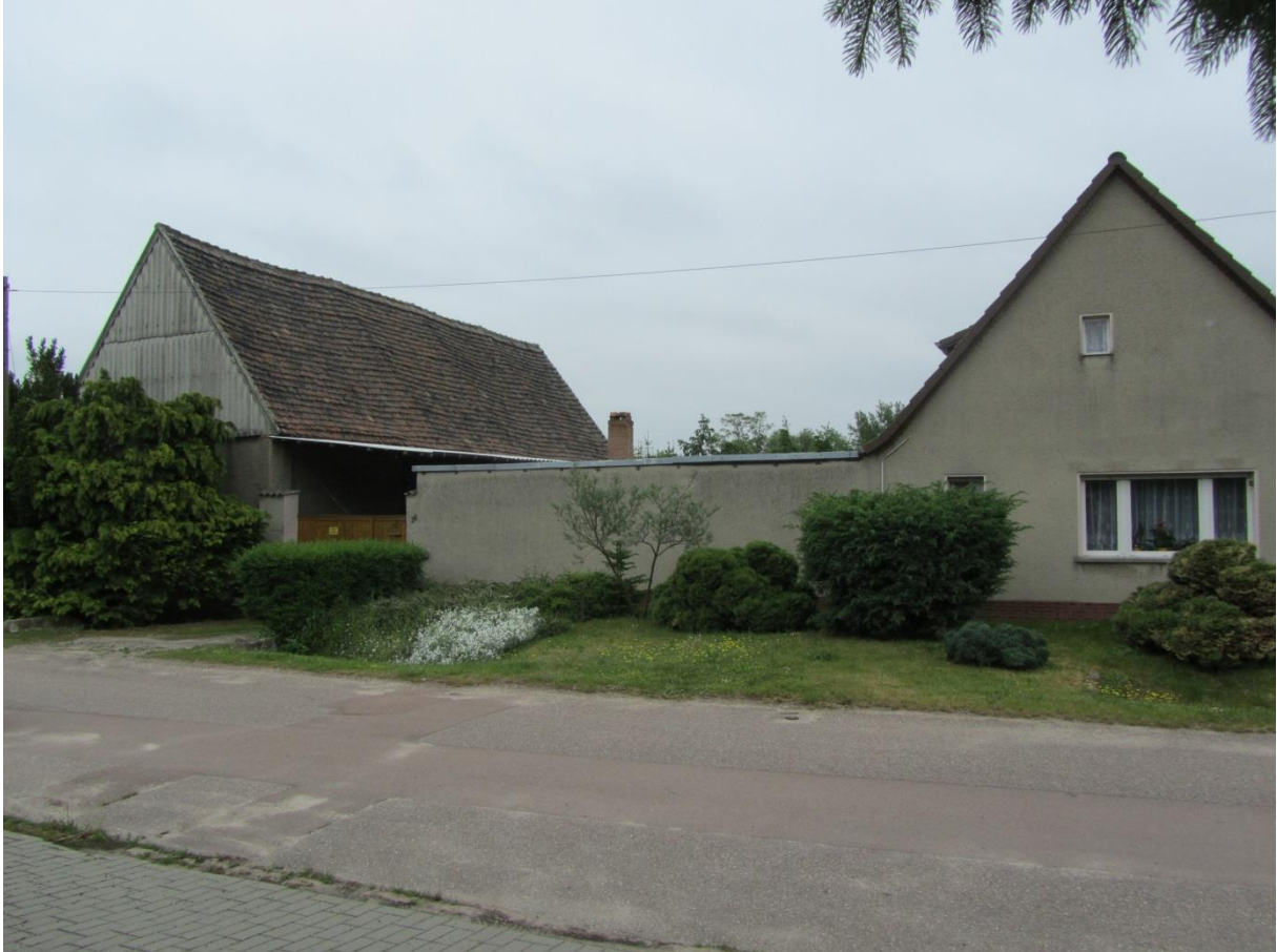
Abb. 16: IO 12b - Sicht auf Nordfassade (es wird angenommen, dass Richtung Windpark Fenster vorhanden sind)
