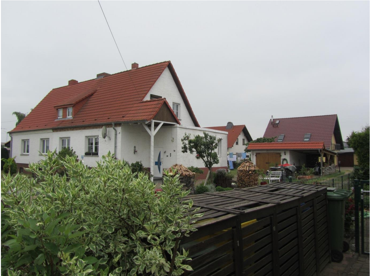
Abb 17: IO 13 - Sicht auf Süd- und Westfassade
