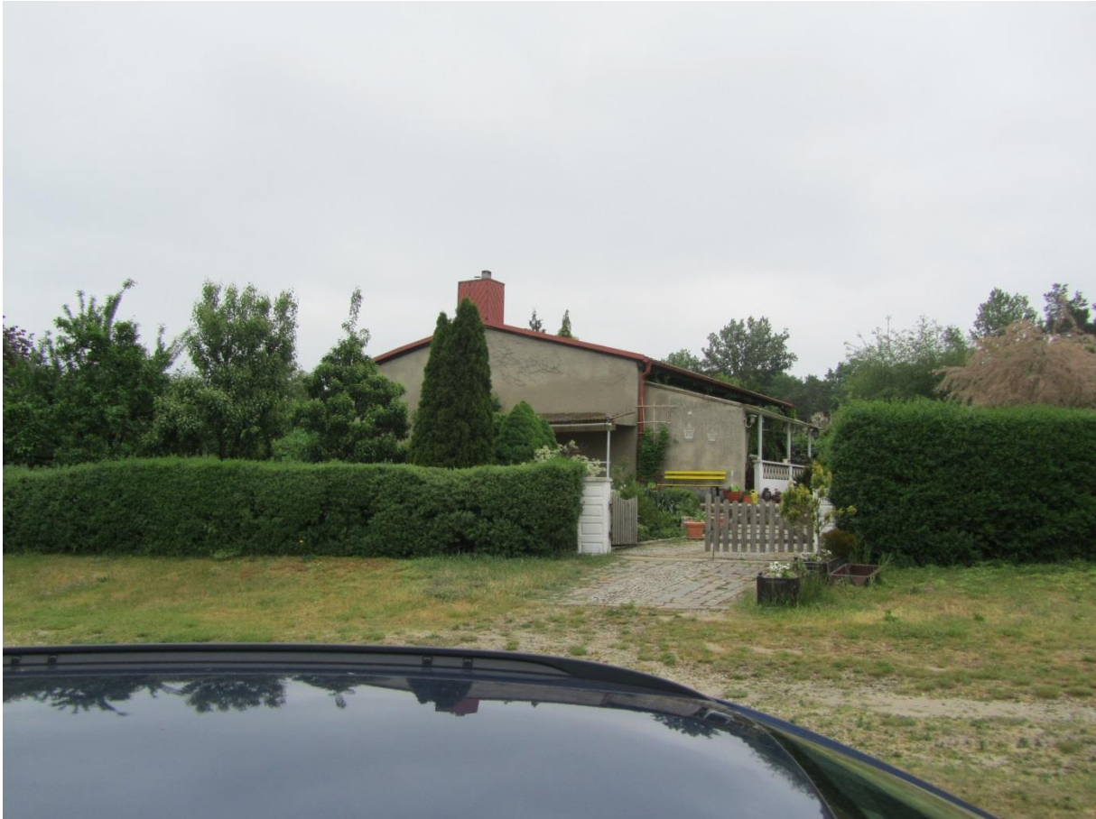
Abb. 4: IO 4 - Sicht auf Westfassade
