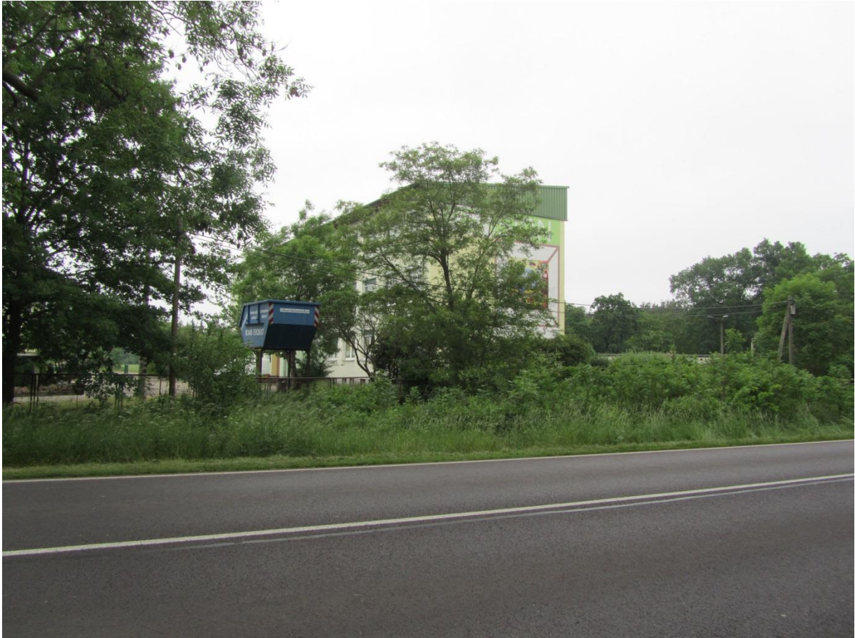
Abb. 2: IO 2 - Sicht auf Süd- und Westfassade
