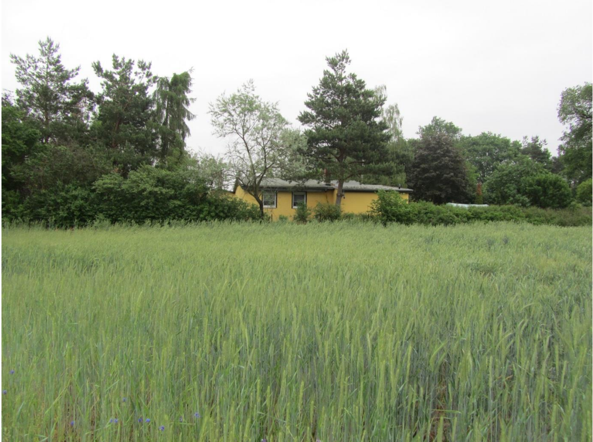
Abb. 8: IO 7b - Sicht auf Westfassade
