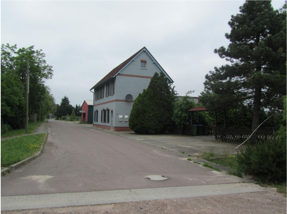
Abb. 15: IO 12a - Sicht auf Süd- und Westfassade (es wird angenommen, dass Richtung Windpark Fenster vorhanden sind)
