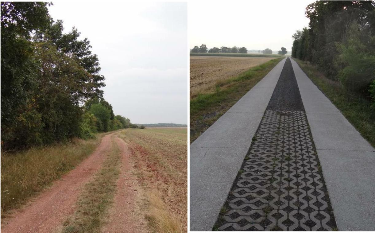
**Abbildung 8:** links: Überwiegend unbefestigter Weg nördlich der Bahntrasse (nur teils leichte Schotterung vorhanden); rechts: Befestigter Weg (Betonplatten mit geschottertem Mittelstreifen) befestigter Bankettbereich
