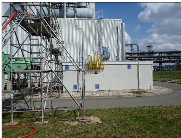
Abb. 4-2: Baustandort im Bereich der KRB/DPH 1/19 mit Blick nach Ost (02.05.2019)
