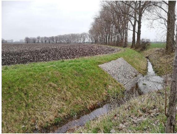
Abbildung 27: Großer Wiesengraben, wasserführend
