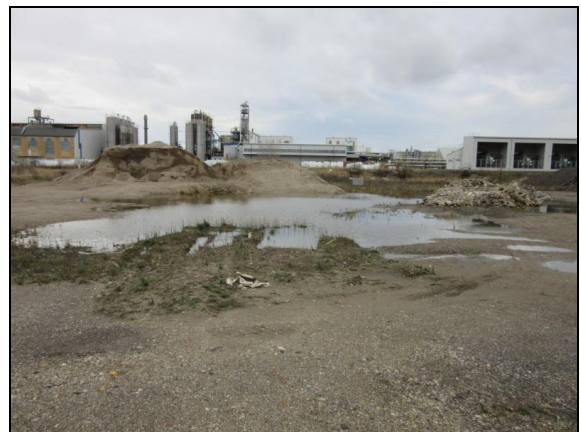
Abbildung 4: Fläche A – wassergefüllte Senken
