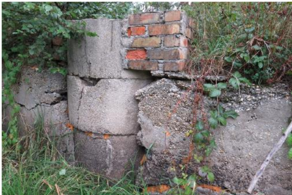
Abbildung 2: Dammmauer und Ablaufbauwerk, teilweise mit Bauschaum verfüllt
