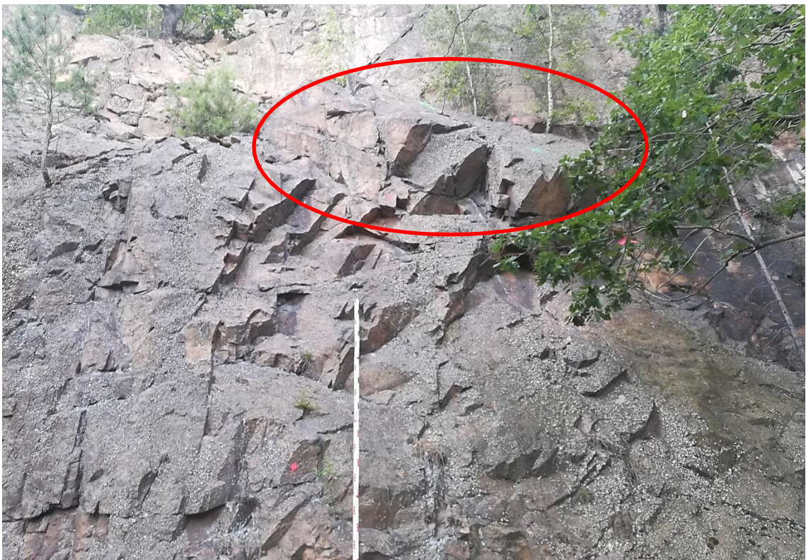
Bild 23: absturzgefährdeter Block im Bereich D Blick nach Norden, 08.07.2019
