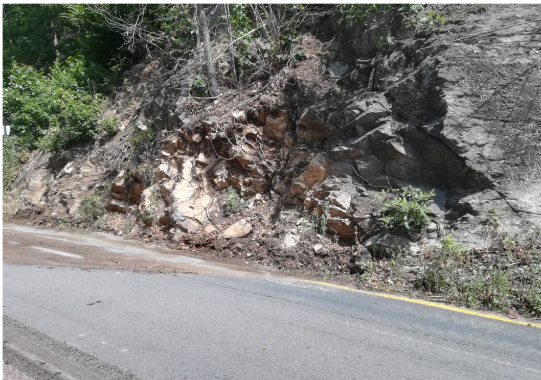
Bild 4: vollständig bis stark verwitterter Bereich unmittelbar an der S 178
