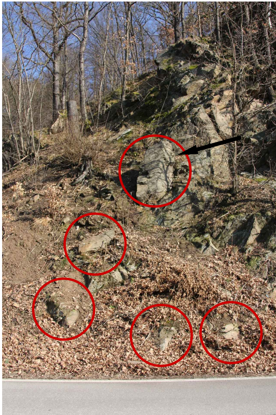
Bild 21: km 0,560 (0,200 m ö. L.); Kluftkörper beräumen
