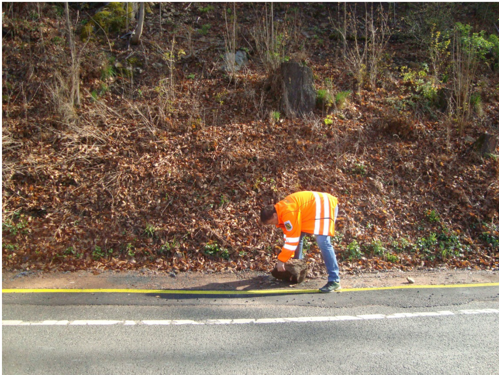
Bild 4: Kluftkörper liegend am Straßenrand, ca. km 0,450, Größe ca. 40/40cm, Beräumung am 18.04.2018
