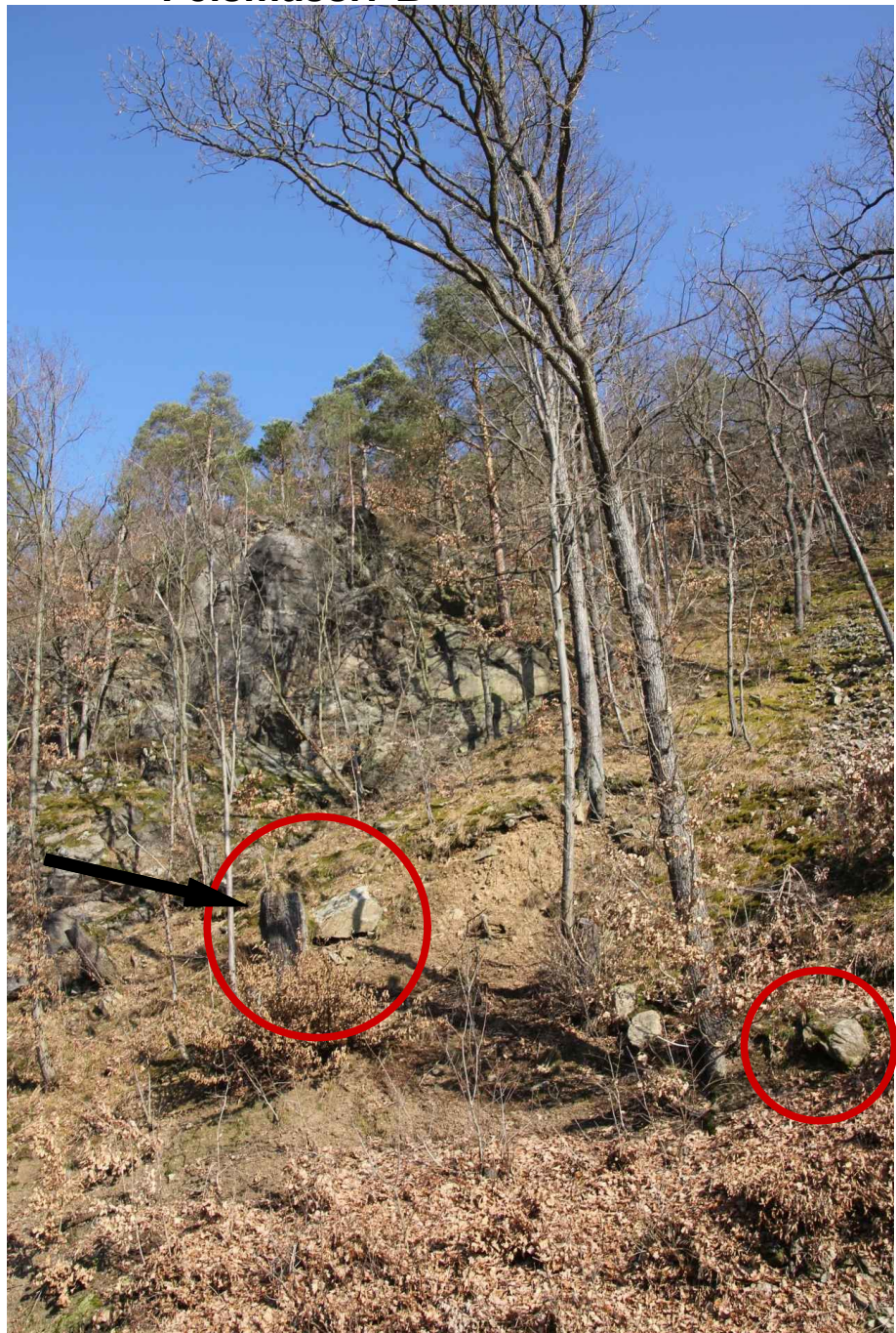
Bild 16: km 0,508 (0,148 m ö. L.); Kluftkörper beräumen (siehe auch Bild17)
