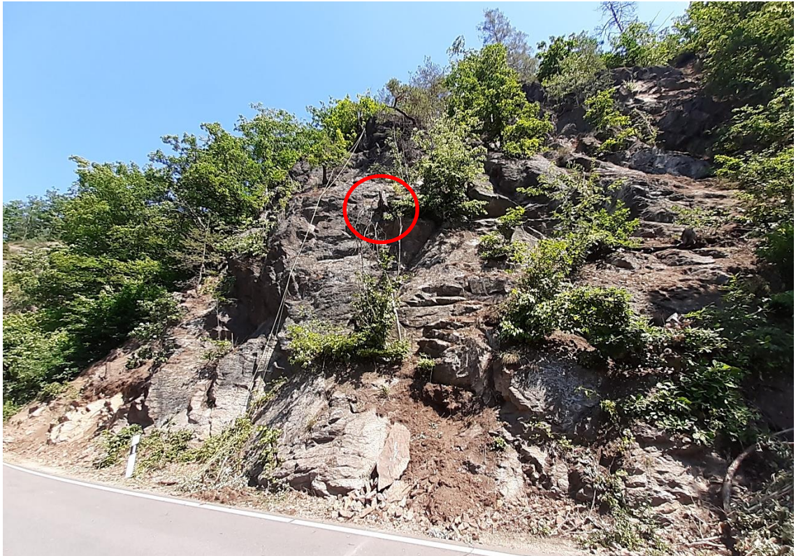
Bild 30: verbliebene absturzgefährdete Kluftkörper im Bereich C, Blick nach Norden, 17.06.2021
