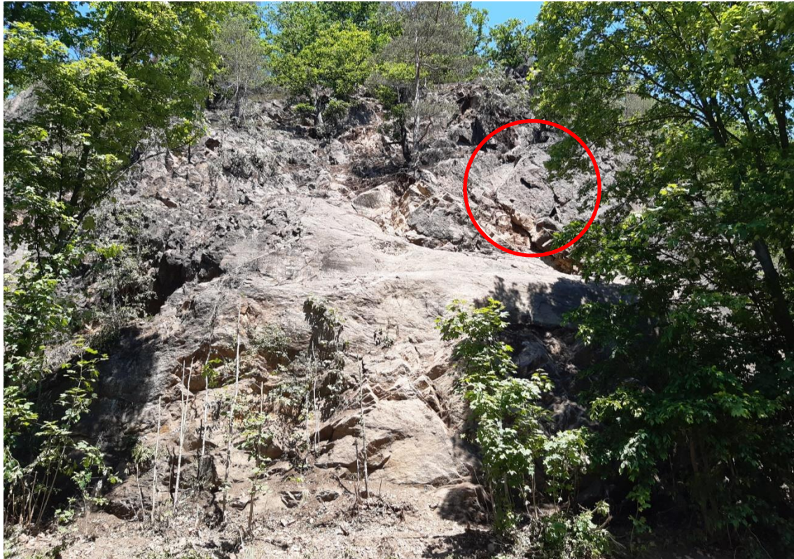
Bild 20: verbliebener absturzgefährdeter Block im Bereich D, Blick nach Nordwesten, 17.06.2021
