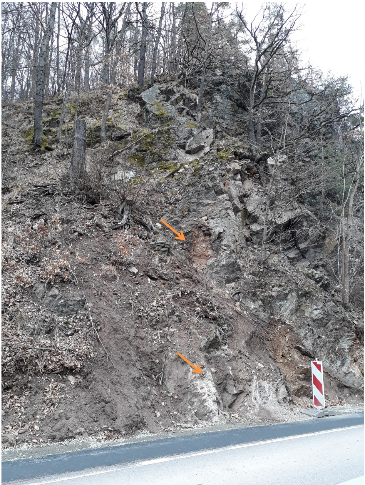
Bild 3: lose Kluftkörper beräumt und Felsklippe am Hangfuß gering profiliert, ca. km 0,560 (0,200 m ö. L.)
