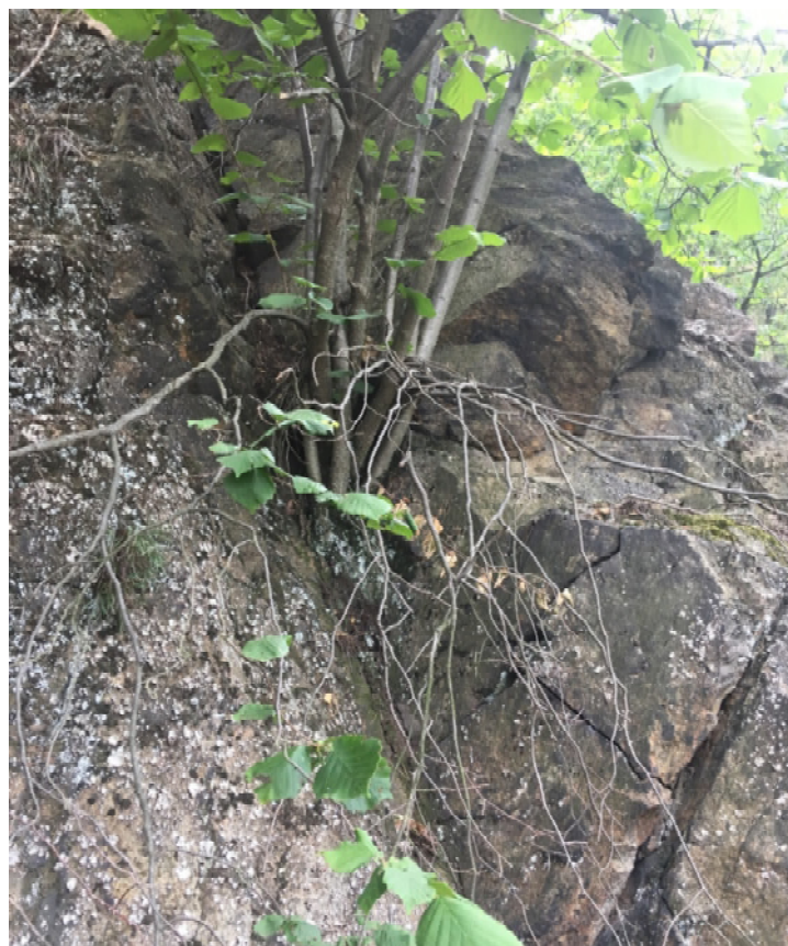
Bild 4: Wurzelsprengung an Felsklippe im Bereich B 2
