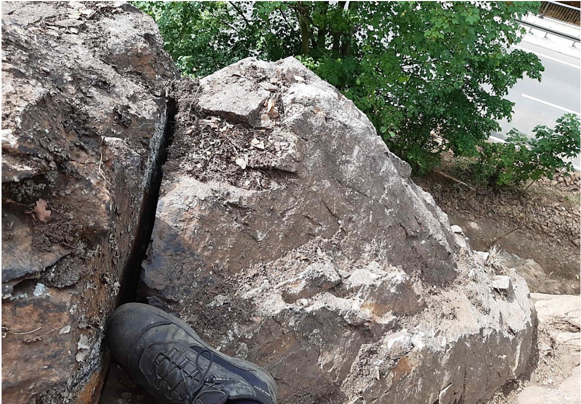
Bild 22: verbliebener absturzgefährdeter Block im Bereich D, Blick nach unten, 15.06.2021
