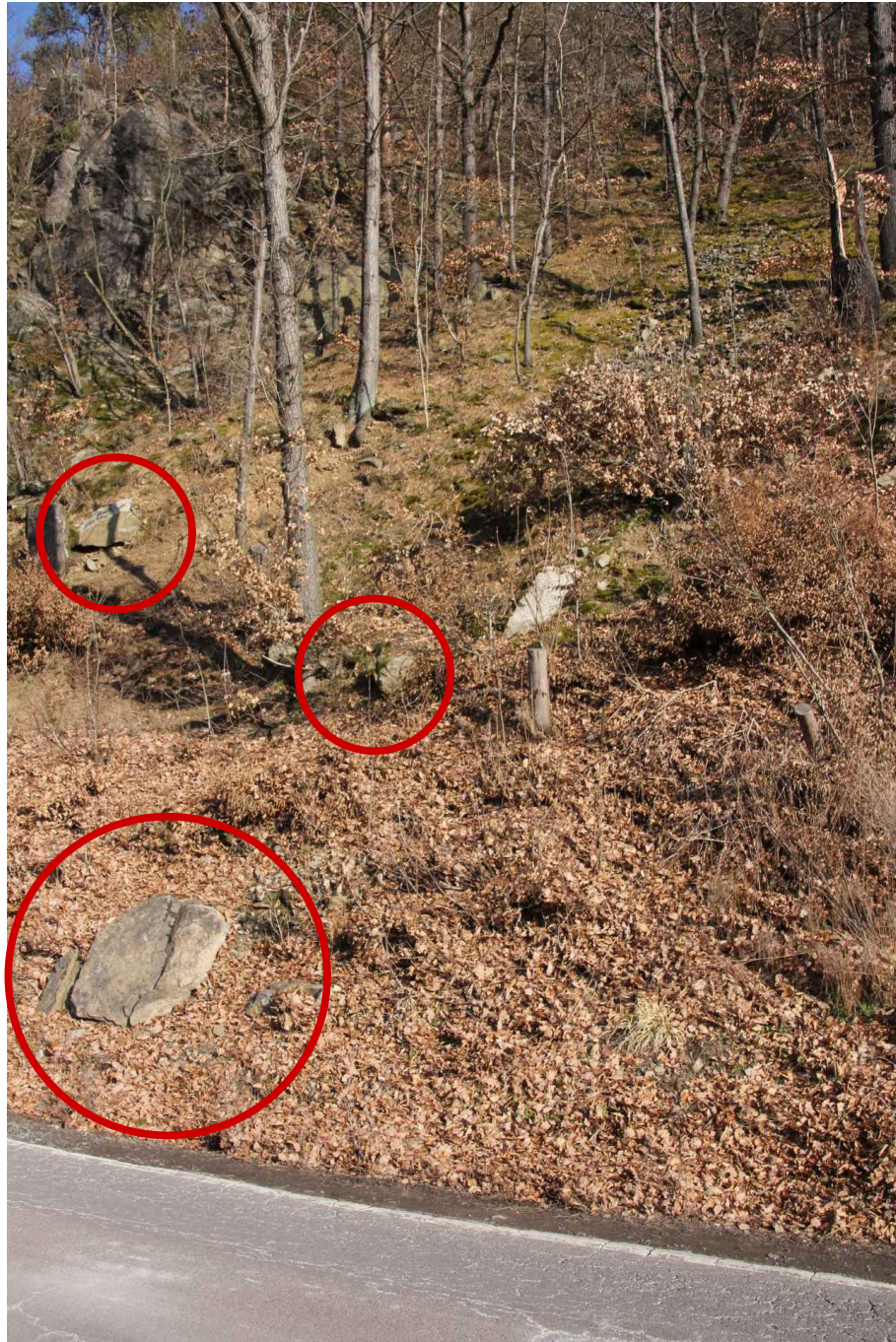
Bild 15: km 0,500 (0,140 m ö. L.); nur teilweise Grasnarbe erkennbar und Kluftkörper im Bereich Fahrbahnrand / Straßengraben (beräumen)
