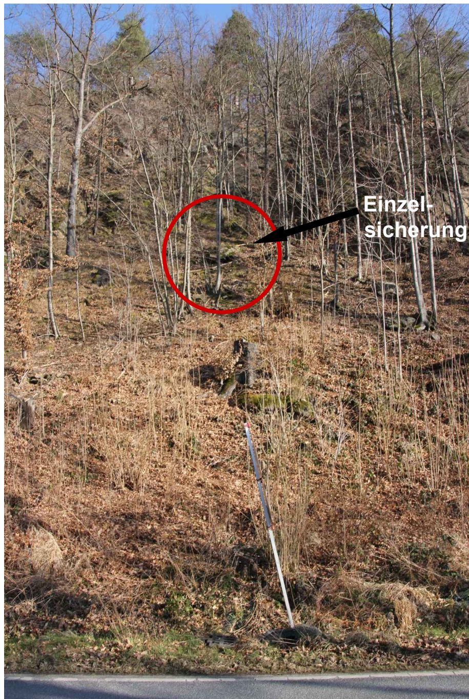
Bild 8: km 0,421 (0,061 m ö. L.); Einzelsicherung einplanen, d.h. Kluftkörper sichern oder beräumen
