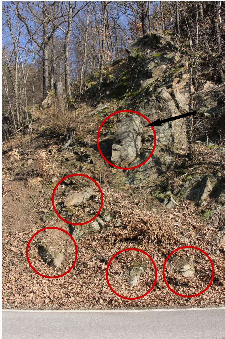
Bild 21: km 0,560 (0,200 m ö. L.); Kluftkörper beräumen
