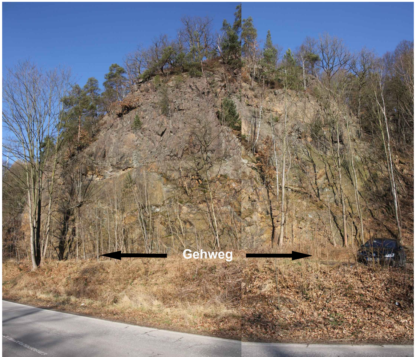
Bild 23: km 0,620 (0,260 m ö. L.); Gesamtansicht Steilhang; Gneis, klüftig mit lokalen Ausbruchbereichen
