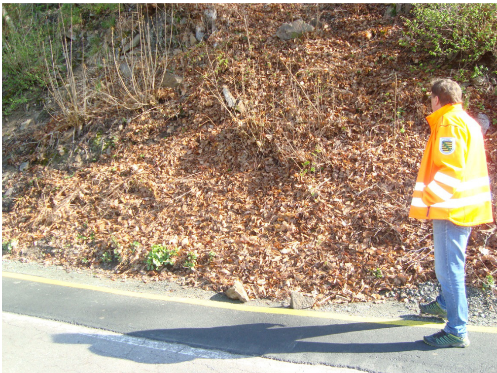
Bild 5: Kluftkörper liegend am Straßenrand, ca. km 0,460, Größe ca. 20/20cm, Beräumung am 18.04.2018
