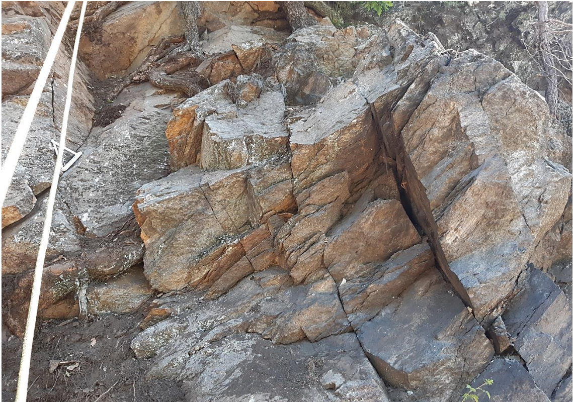
Bild 28: absturzgefährdete Kluftkörper im zu vernetzenden Bereich C, Blick nach Nordosten, 17.06.2021
