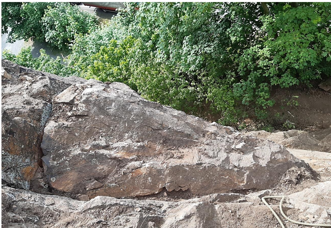
Bild 21: verbliebener absturzgefährdeter Block im Bereich D, Blick nach unten, 15.06.2021
