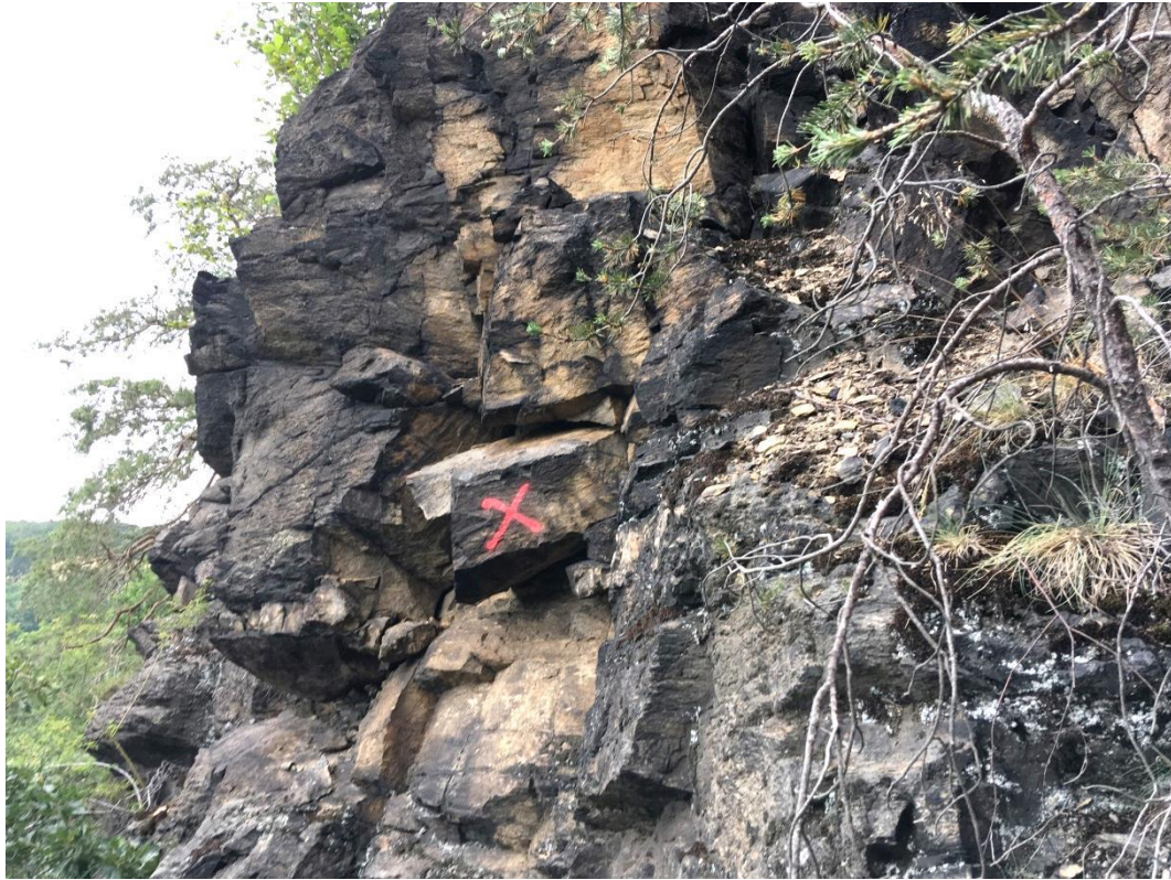
Bild 1: Absturzgefährdeter Block Bereich E 4
