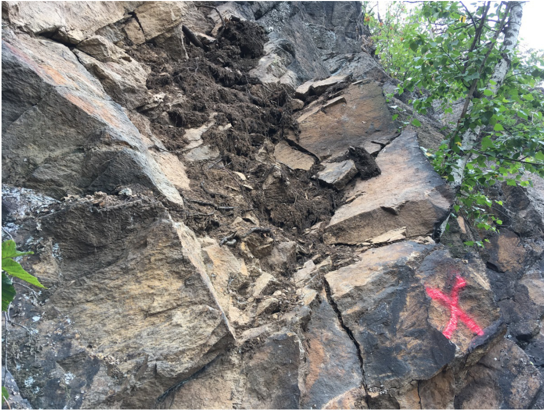
Bild 5: weitere absturzgefährdete Blöcke im Bereich B 4, Blick Richtung Osten
