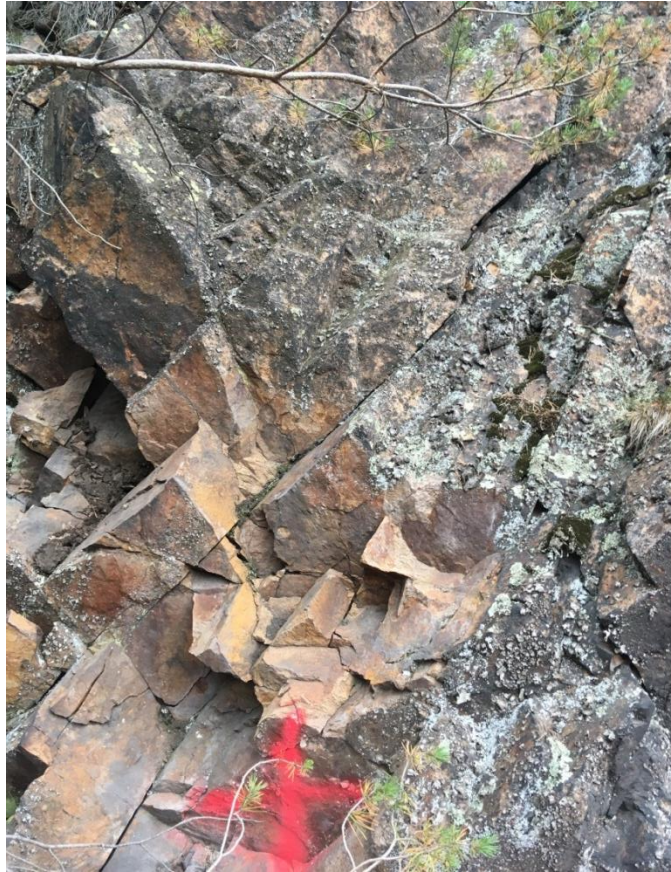
Bild 1: lose, zu beräumende Blöcke im Bereich D4
