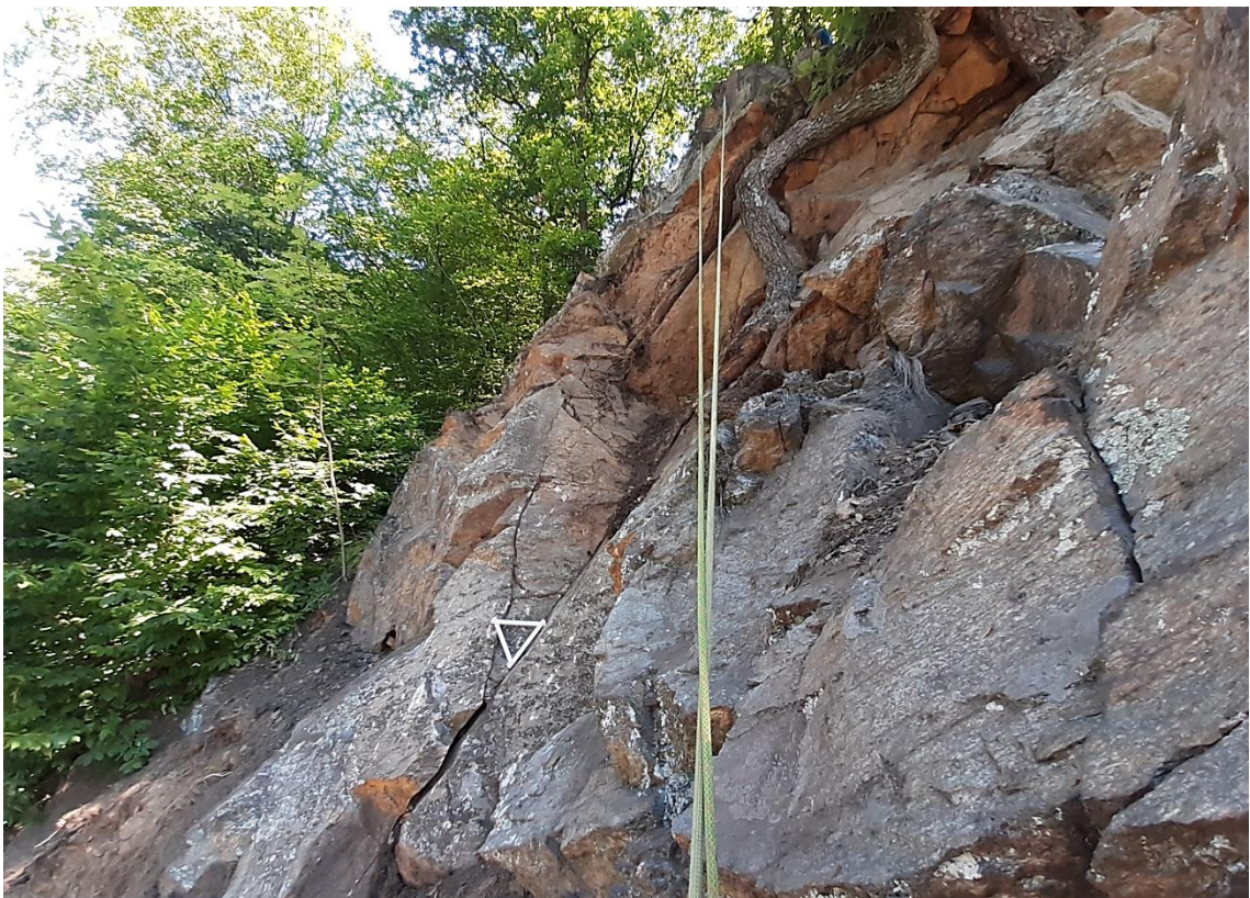
Bild 27: absturzgefährdete Kluftkörper im zu vernetzenden Bereich C, Blick nach Norden, 17.06.2021
