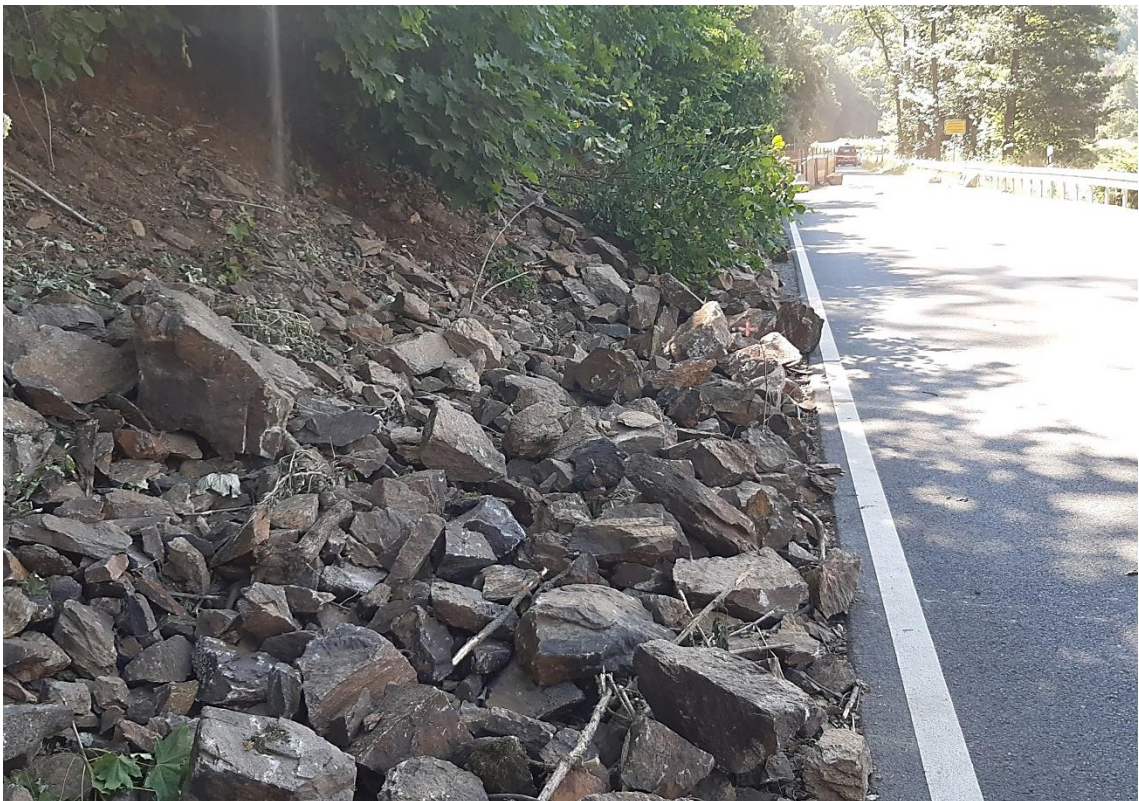
Bild 17: beräumte Kluftkörper im Bankettbereich, Bereich B Blick nach Südosten, 17.06.2021
