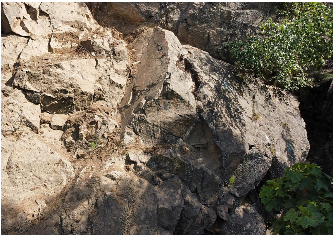
Bild 25: absturzgefährdeter Block im Bereich D, Blick nach Westen, 15.06.2021
