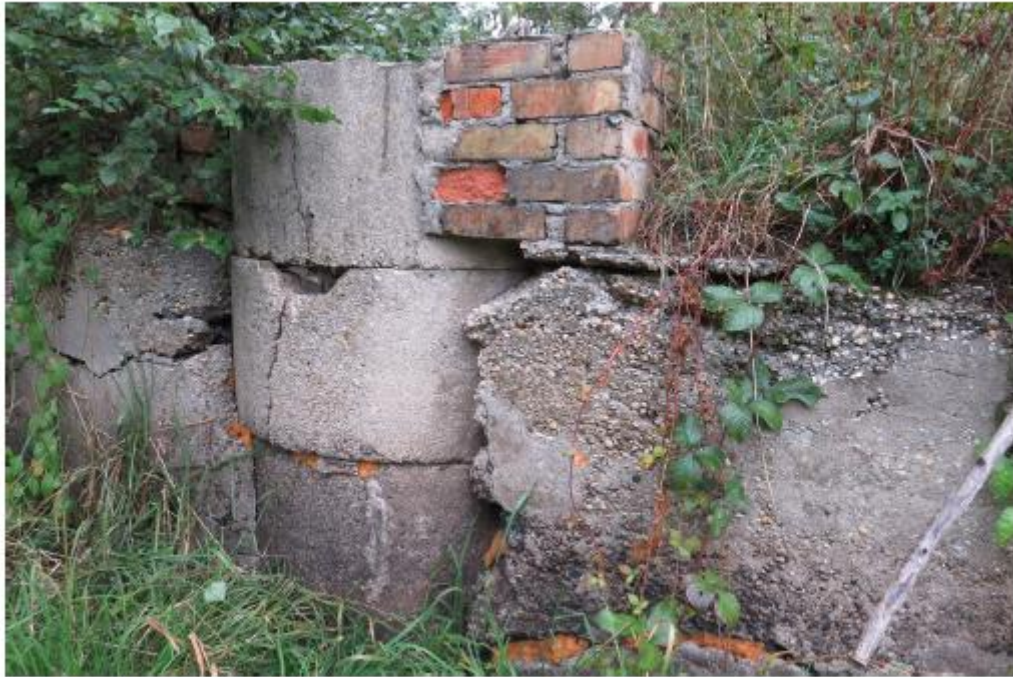
Abbildung 2: Dammmauer und Ablaufbauwerk, teilweise mit Bauschaum verfüllt
