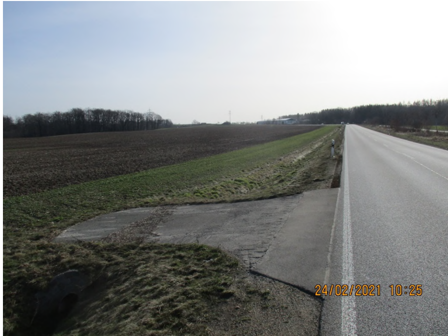
Foto 1: Stand auf Straße S286 mit ehem. Zufahrt zur Start- und Landebahn des ehem. Agrarflugplatzes (Stand: S263; Blickrichtung: Osten)
