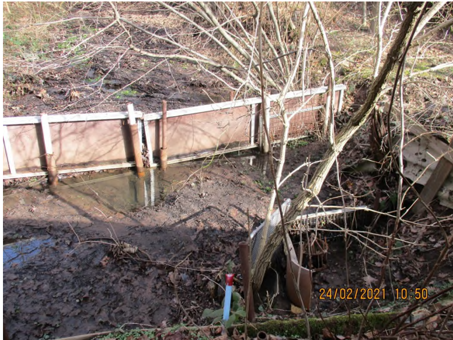
Foto 5: Sammelpunkt Grabenwasser und Überlauf in kanalisiert Entwässerung (Stand: südöstlich AA; Blickrichtung: Detailfoto)
