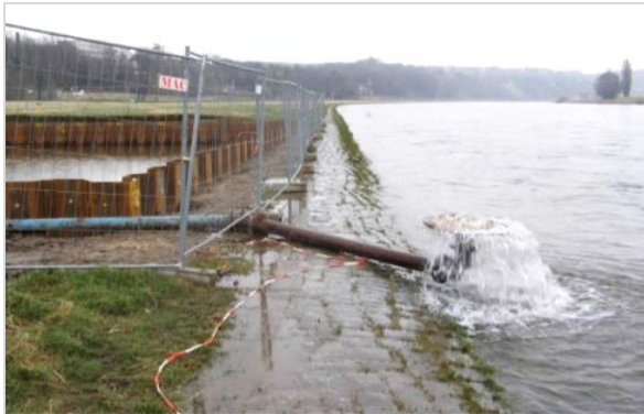
Sauerstoffanreicherung von eingeleitetem Wasser aus der Baugrube des Nord-Widerlagers (17.03.2008 vgl. Kap. 6.2.4.2, S. 136)
