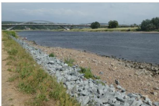
Im Frühling 2018 wurden LRT-Flächen auf längeren Uferabschnitten mit Schottersteinen überdeckt.
