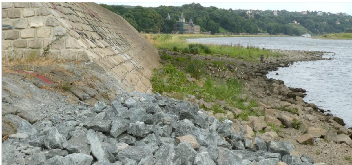
Abb. 19: Uferbeschaffenheit am Nordufer unter der Brücke (im Vordergrund eine rezente Steinschüttung, die nicht im Zusammenhang mit der Brücke steht. Quelle: KifL 21-06-2018)
