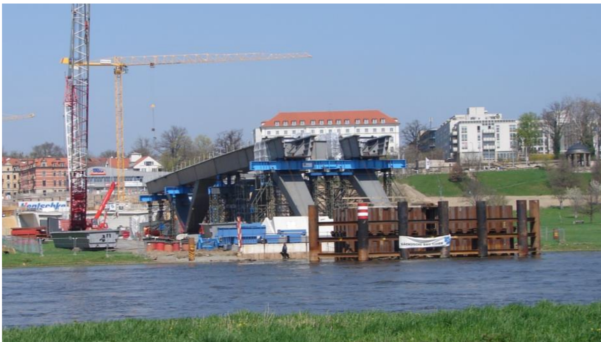
Abb. 4: Temporäre Tragekonstruktion aus Spundwänden in der Elbe (Nordufer, Blick nach Norden, 17.4.2010)
