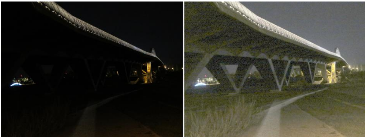
Abb. 77: Reichweite der Treppenbeleuchtung
