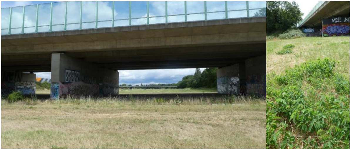
Abb. 82: Brücke der Autobahn der 6-spurigen A 4 über die Kaditzer Flutrinne mit Wiesenknopfpflanzen (Blick nach Osten) (Quelle: KfL Juni 2018)
