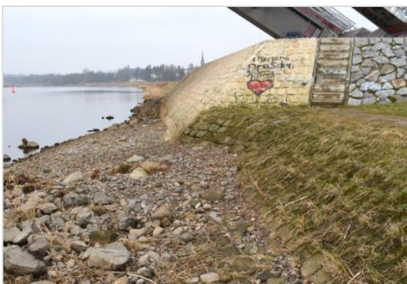
Nordwiderlager und historische Uferbefestigung aus dem 19. Jahrhundert
