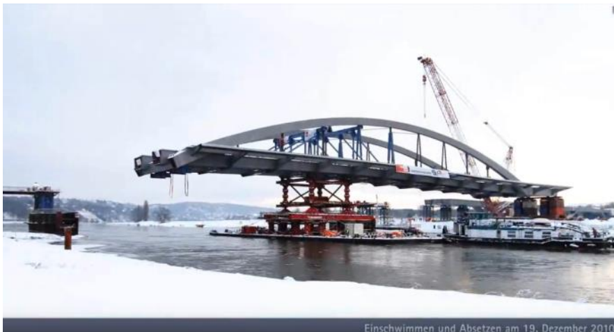
Einschwimmen mit- tels Pontons 19. Dezember 2010
