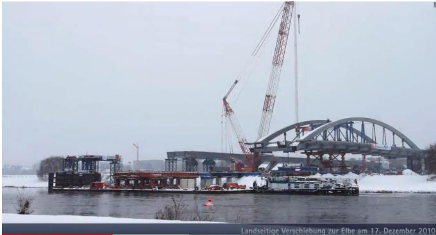
Verschieben auf Gleitschienen vom Vormontageplatz zur Übergabestelle am Elbufer 17. Dezember 2010
