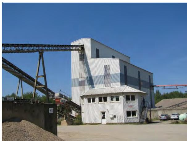
Abbildung 12: Kieswerk, Brech- und Klassieranlage
