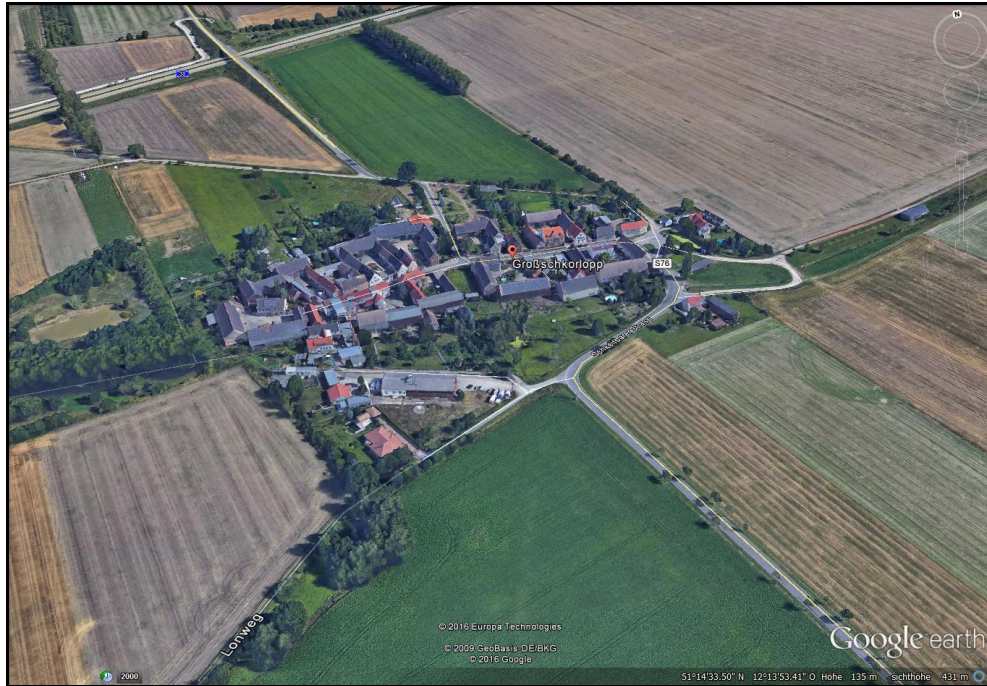
Bild 7: Ansicht von Großschkorlopp. Blickrichtung Nord. Quelle: Google Earth.
