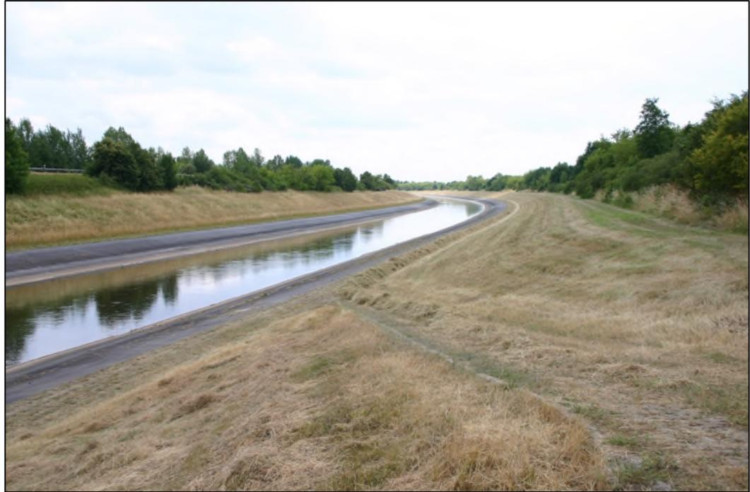
Abbildung 1: Verlegestrecke der Weißen Elster („Betonelster“) in Höhe des Gewerbegebietes Knautnaundorf.
