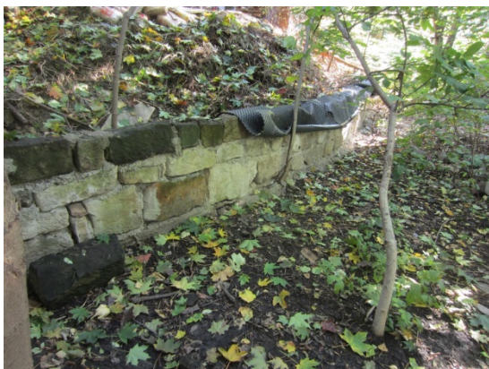
Bild 11: Höhe Ansatzpunkt KRB 10 bei Mauer
