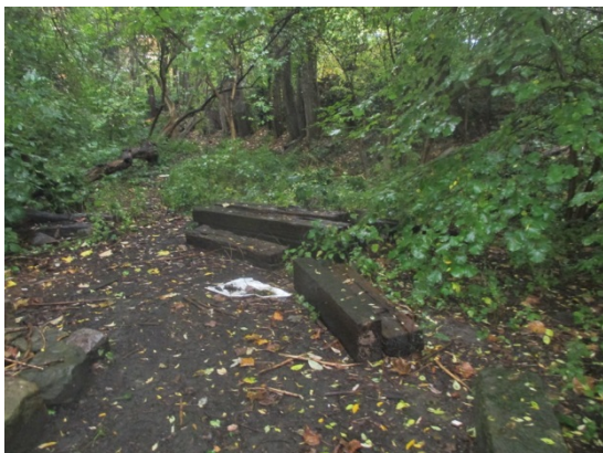
Bild 9: Kaitzbach 3. BA – Grill- und Lagerfeuerplatz – KRB 9
