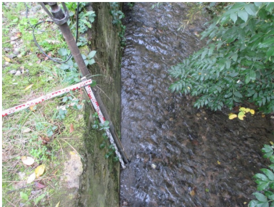
Bild 3: Ausführung KRB im Kaitzbach – KRB 2
