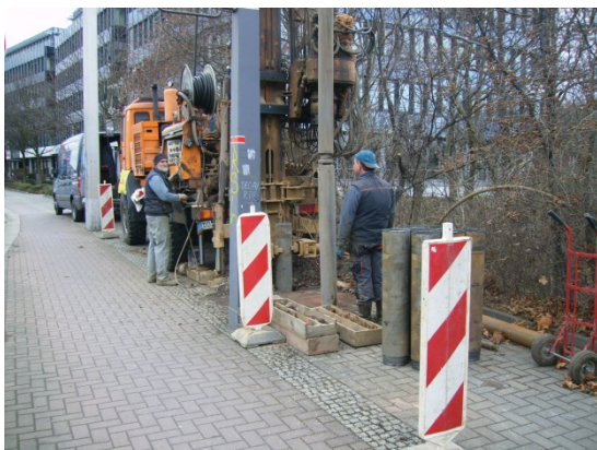
Bild 9: Durchführung der Baugrundbohrung B 305
