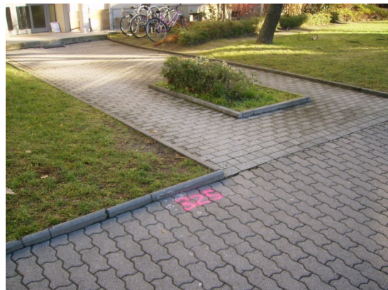
Bild 6: Bereich Gehweg/ Grünfläche vor Wohngebäuden Nürnberger Straße N
