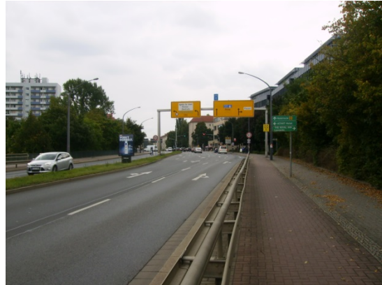
Bild 2: Auffahrt Nossener Brücke
