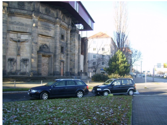
Bild 4: Bereich Gehweg Nürnberger Str. S
