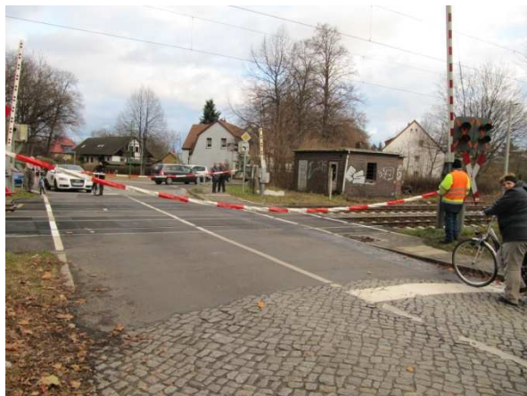
Bild 20 und Bild 21 BÜ-Sicherung mit einem Bahnwärter (linkes Bild) und Baustraßen-BÜ mit Höhenbegrenzer und Abzäunung (rechtes Bild).
