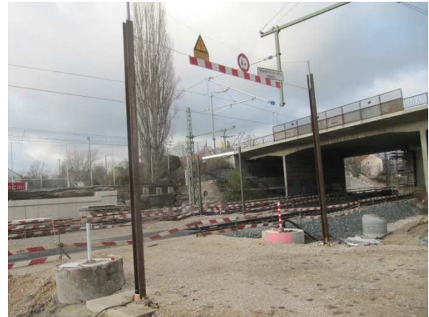
Bild 20 und Bild 21 BÜ-Sicherung mit einem Bahnwärter (linkes Bild) und Baustraßen-BÜ mit Höhenbegrenzer und Abzäunung (rechtes Bild).
