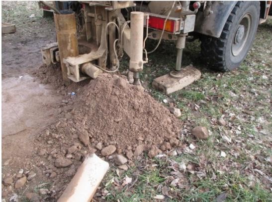
Bild 7: Durchführung der Baugrundbohrung B 104
