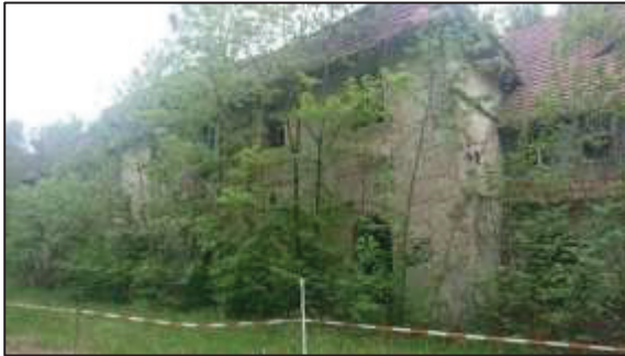
Foto 1: Blick auf die Ostseite der Niedermühle
