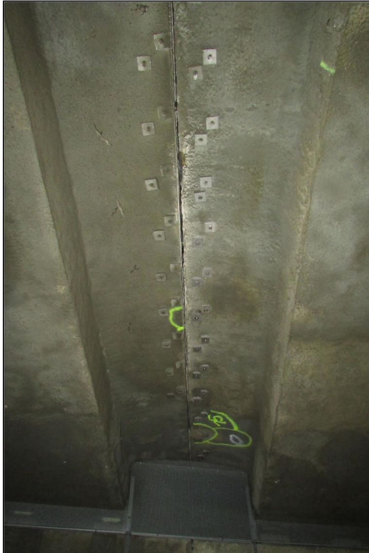
Foto 7: Kurzer Abschnitt der Mittelfuge unterhalb der Brücke über die Fabrikstraße
