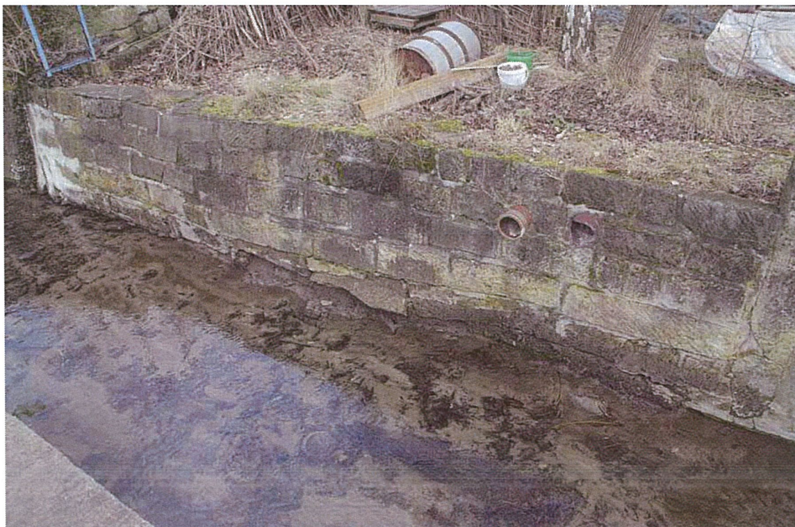
Foto 10: Ufermauer mit Einleitstellen Flurstück 525 bei Station 4+351,23
