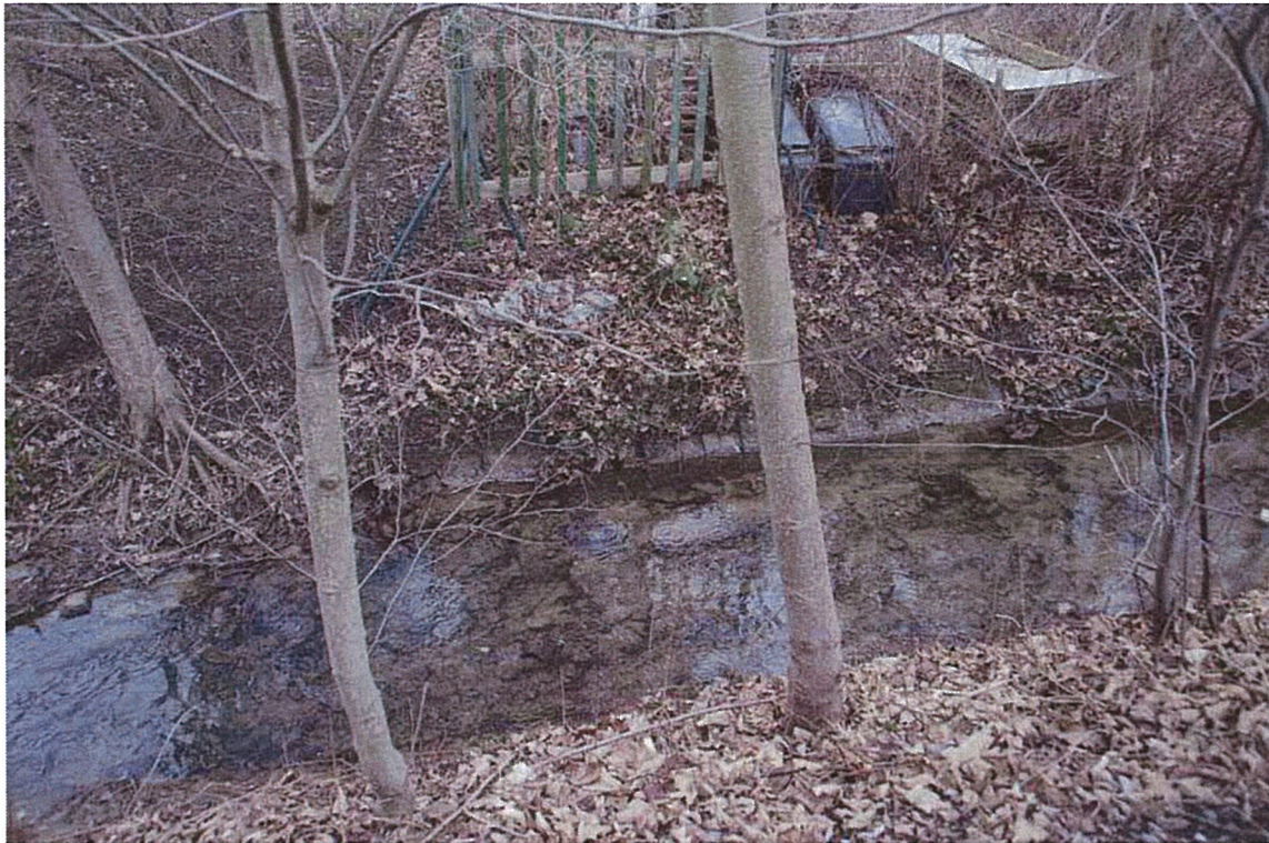
Foto 5: Die Ufer sind mit Sandstein- Grundsteinen befestigt (gesamtes Bearbeitungsgebiet außer bei Ufermauern)
