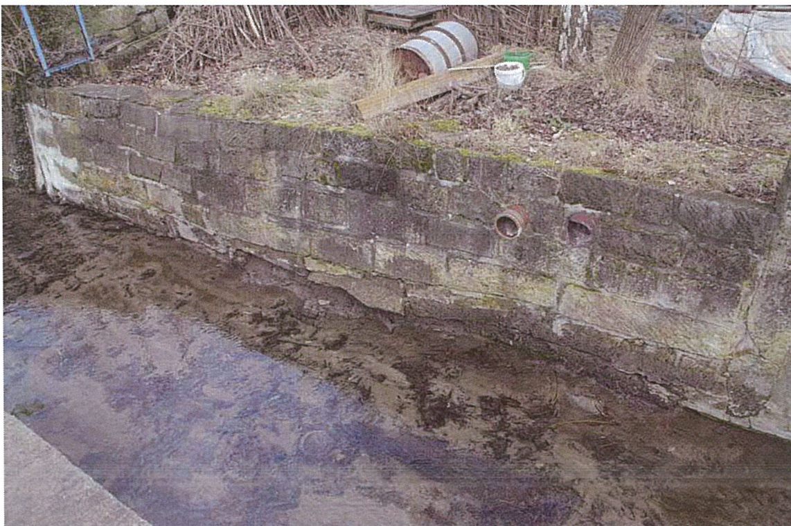
Foto 10: Ufermauer mit Einleitstellen Flurstück 525 bei Station 4+351,23
