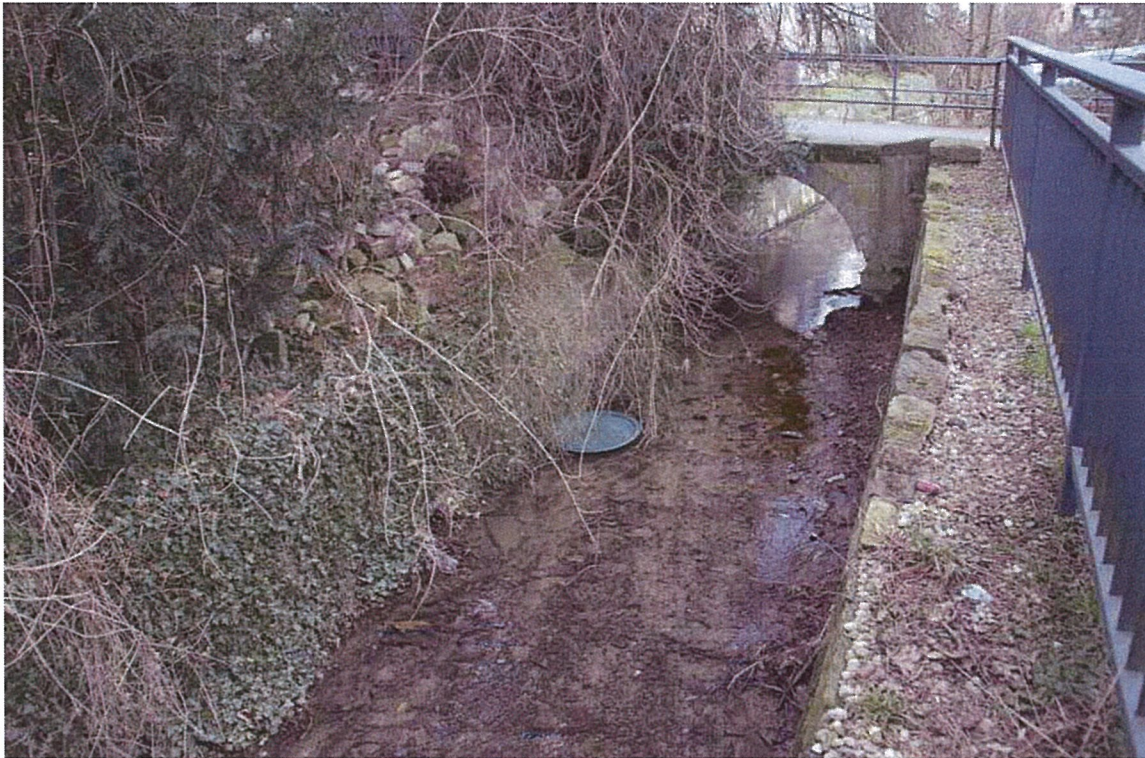
Foto 7: eingegengtes Bachquerprofil vor Durchlass 4 (Blick stromaufwärts)
