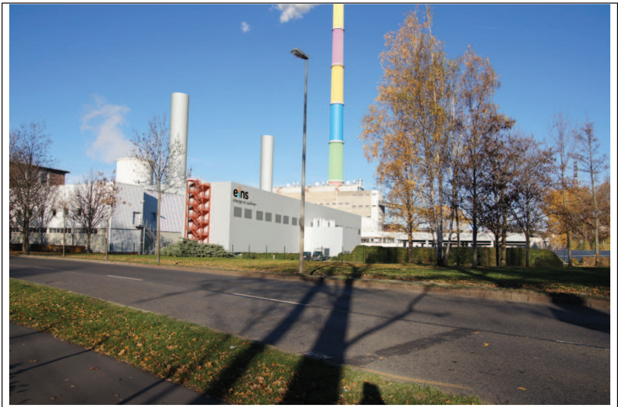
Abbildung 28: Visualisierung des neuen Baukörpers des MHKW, Blickpunkt von der Blankenburgstraße Blickrichtung Nordost
