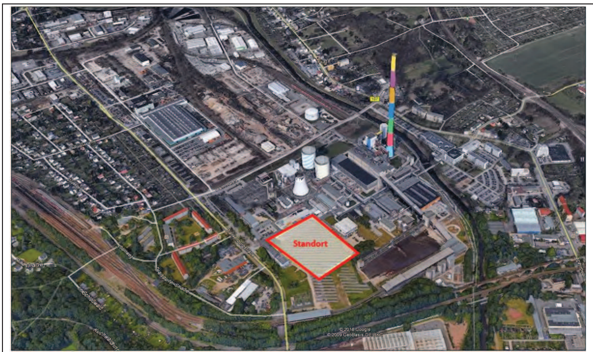
Abbildung 23: Schrägluftbild von Standort und Umfeld, Ansicht von Süd (Quelle: google earth)
