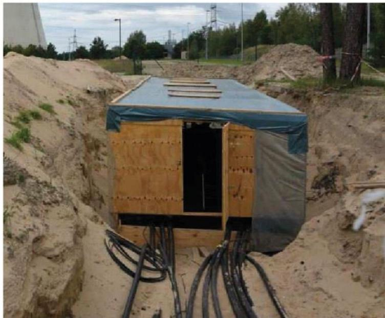
Abbildung 4: Beispiel Einhausung Muffengrube
