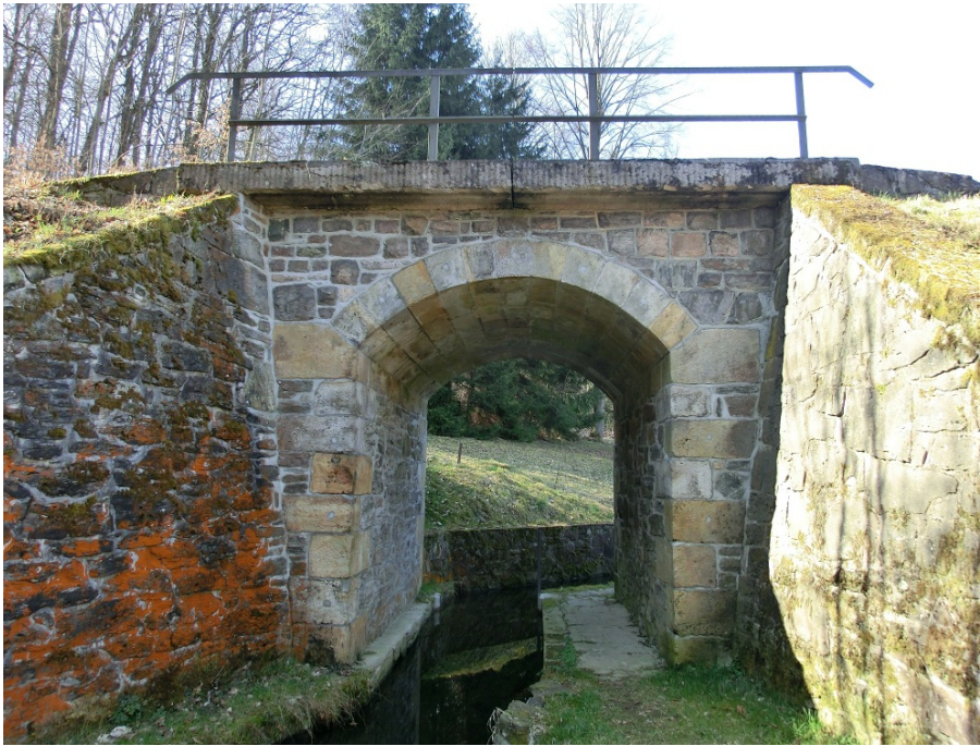
Abbildung 1: Bauwerk 1, Gewölbebrücke über Mühlgraben
