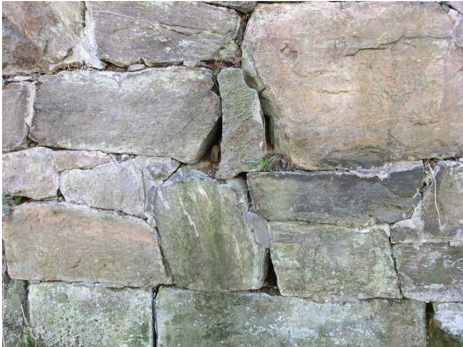
Abbildung 7: Bauwerk 5, Fugen in der Stützmauer
