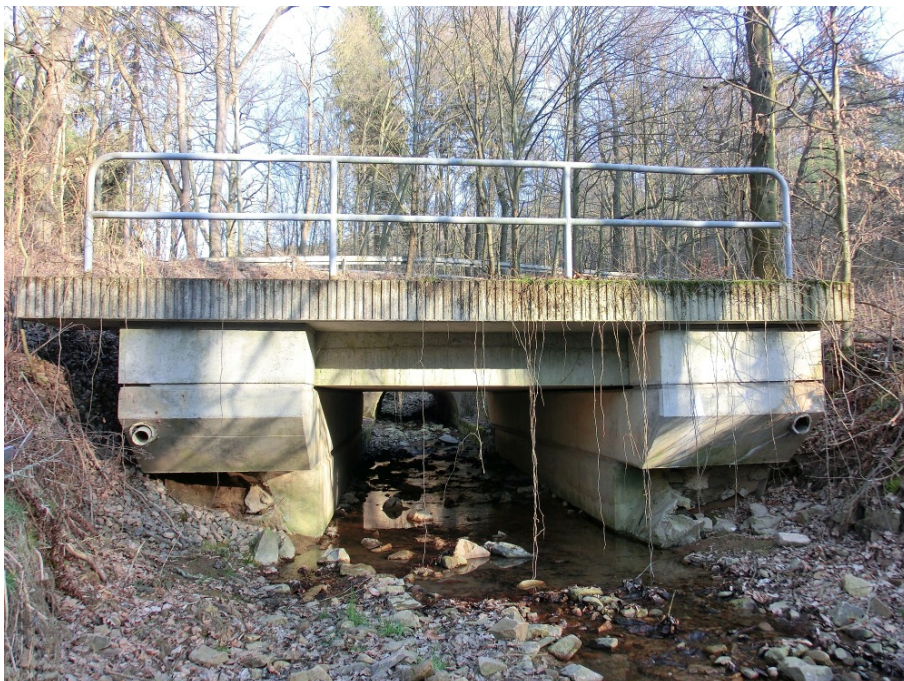
Abbildung 14: Bauwerk 10, Stahlbetonbrücke über Tiefenbach
