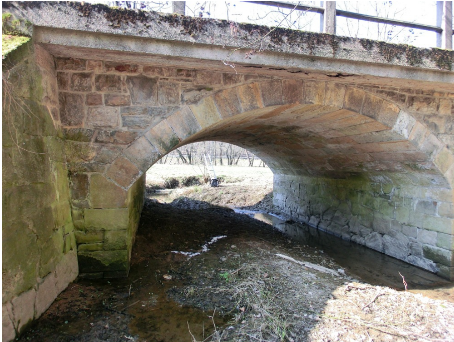
Abbildung 23: Bauwerk 13, Gewölbebrücke über einen Bach
