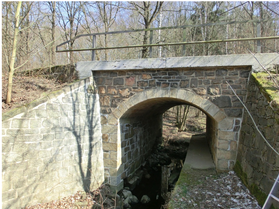
Abbildung 21: Bauwerk 12, Gewölbebrücke über einen Bach
