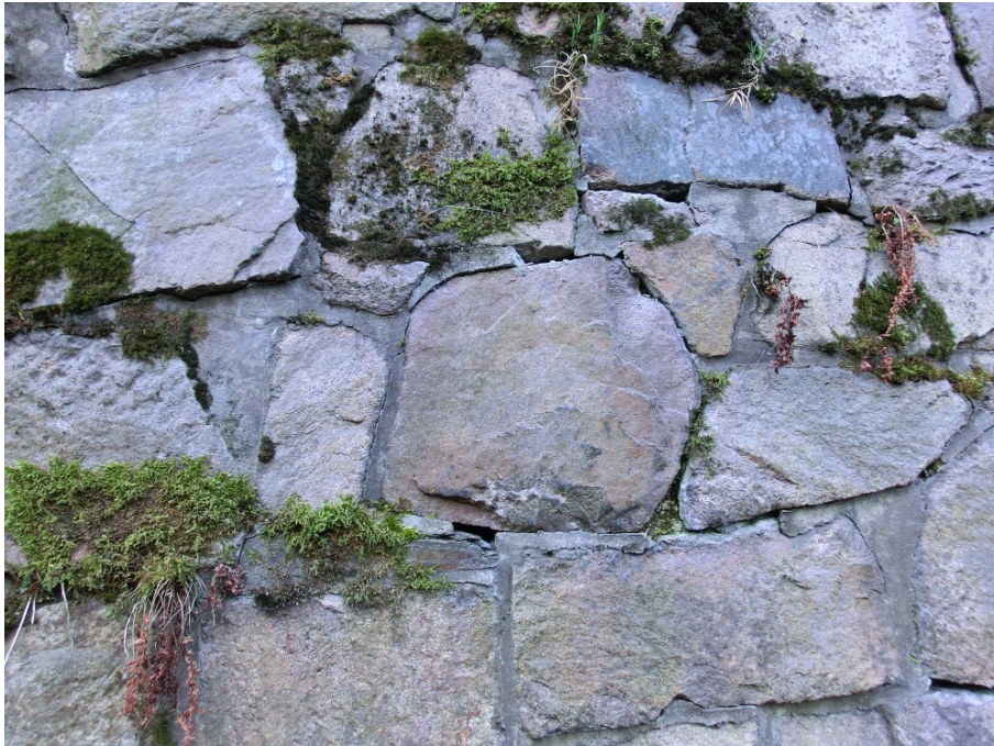
Abbildung 13: Bauwerk 9, Fugen in der Stützmauer
