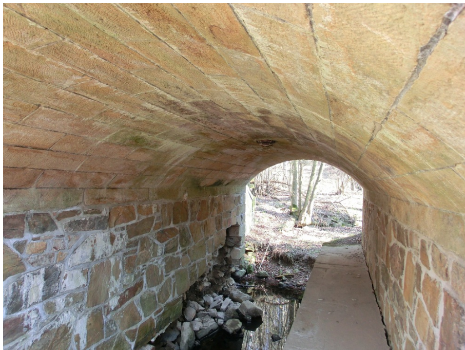
Abbildung 22: Bauwerk 12, Gewölbe innen
