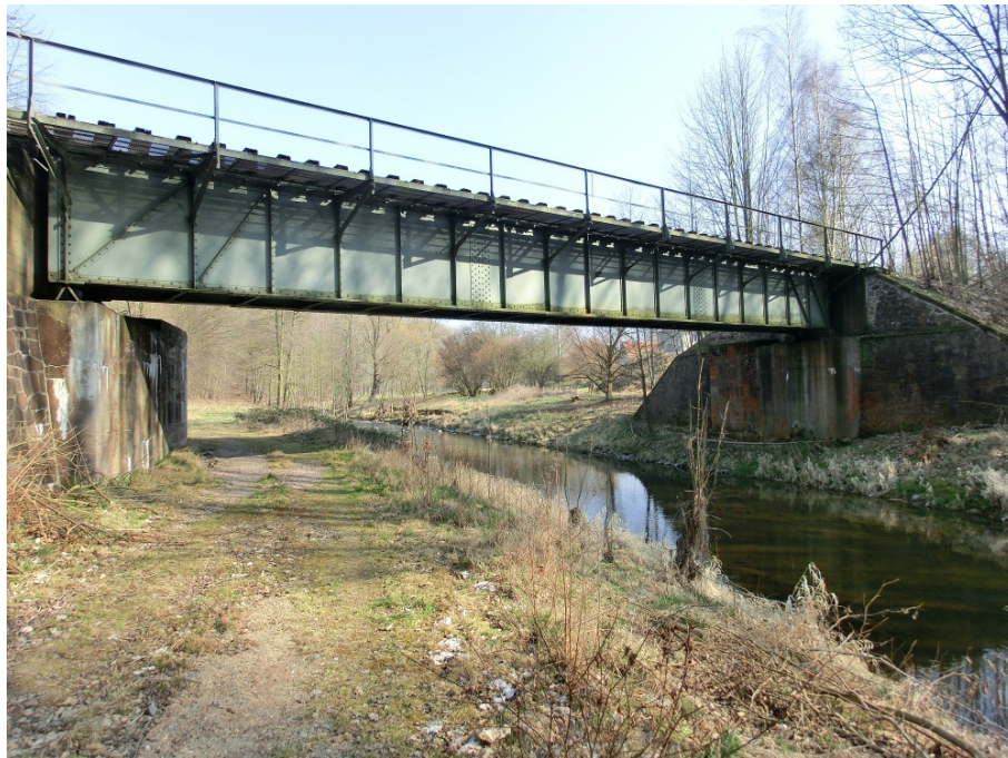
Abbildung 30: Bauwerk 17, Stahlbrücke über Striegis
