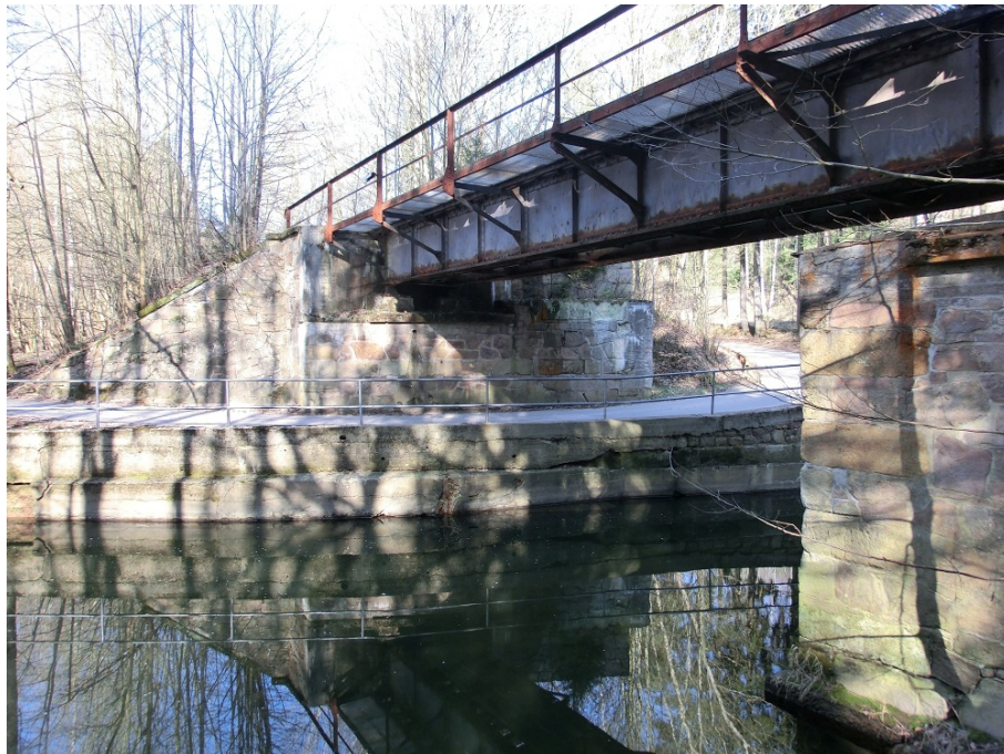
Abbildung 9: Bauwerk 7, Stahlbrücke über Striegis
