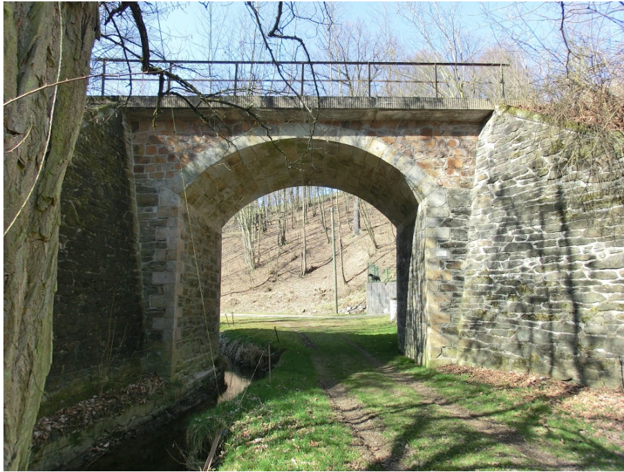
Abbildung 3: Bauwerk 3, Gewölbebrücke über Weg und Mühlgraben
