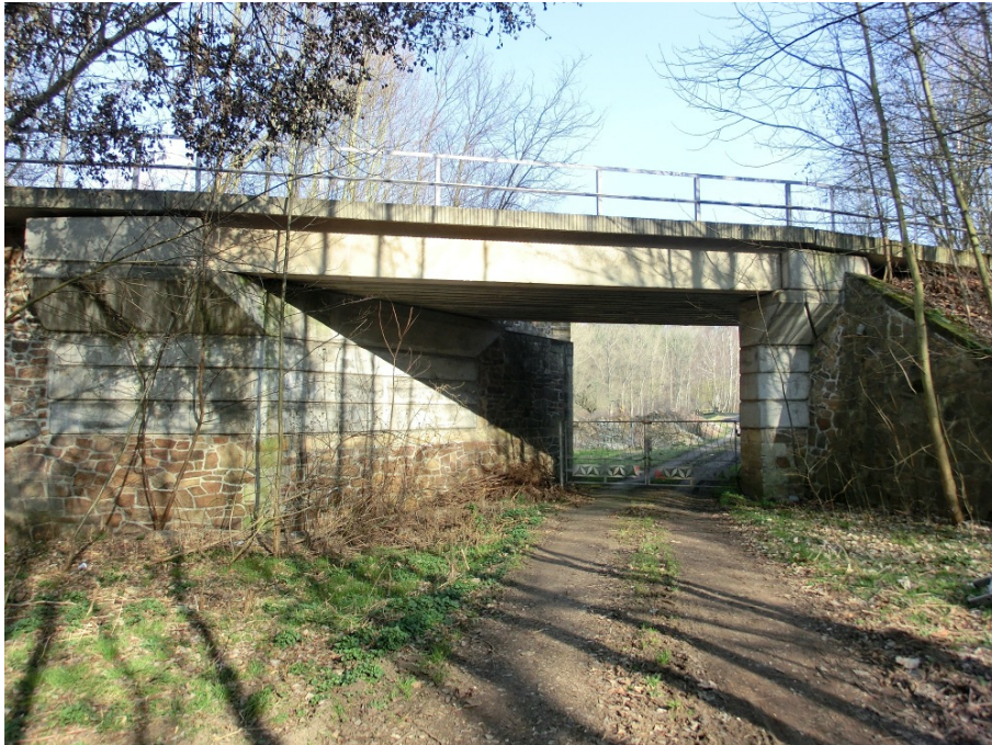
Abbildung 27: Bauwerk 16, Stahlbetonbrücke über Weg
