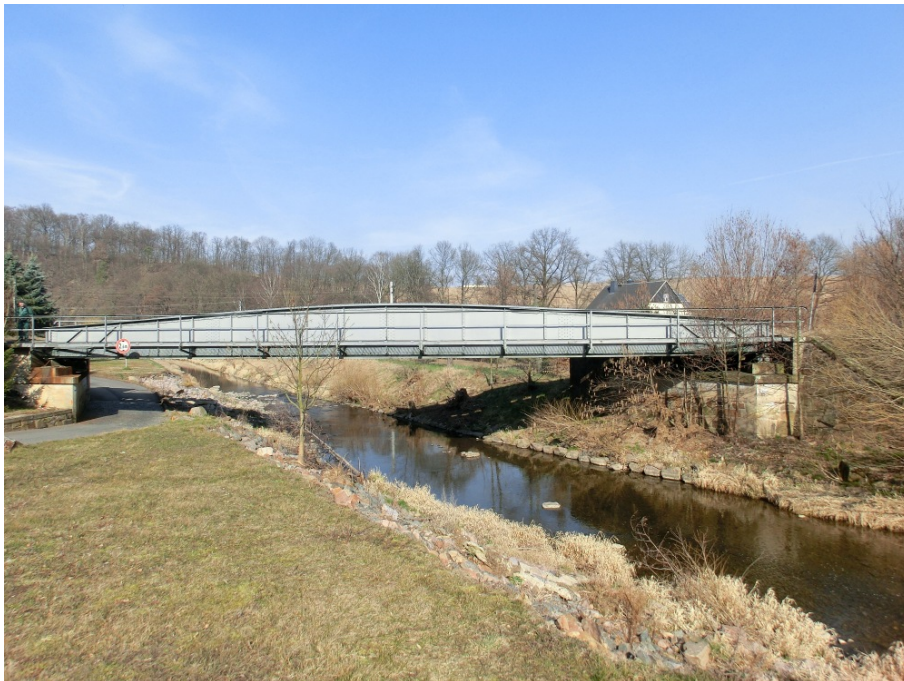
Abbildung 25: Bauwerk 15, Stahlbrücke über Striegis
