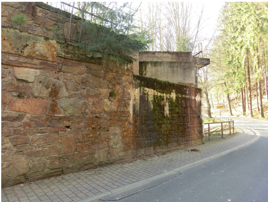
Abbildung 8: Bauwerk 6, Stützmauer der Holzbrücke über Ortsstraße Berbersdorf
