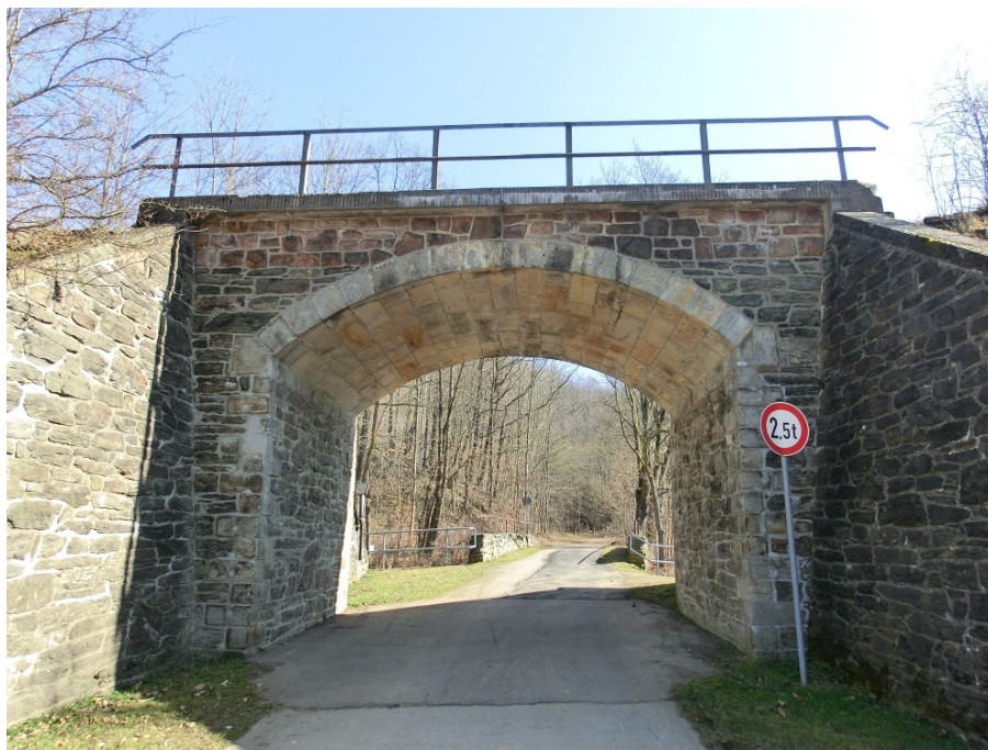
Abbildung 2: Bauwerk 2, Gewölbebrücke über Ortsstraße Schlegel
