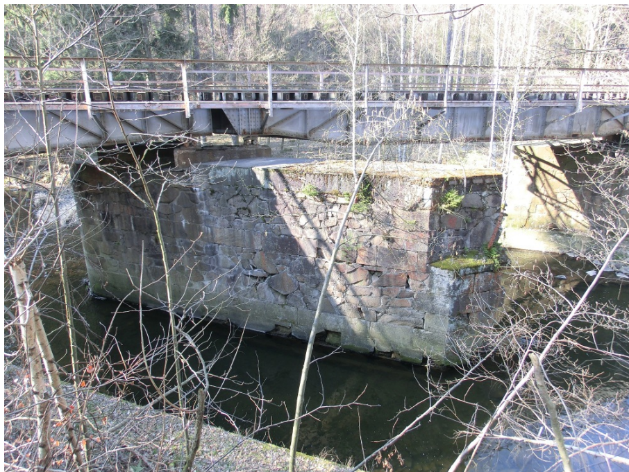
Abbildung 10: Bauwerk 8, Zweifeld-Stahlbrücke über Striegis
