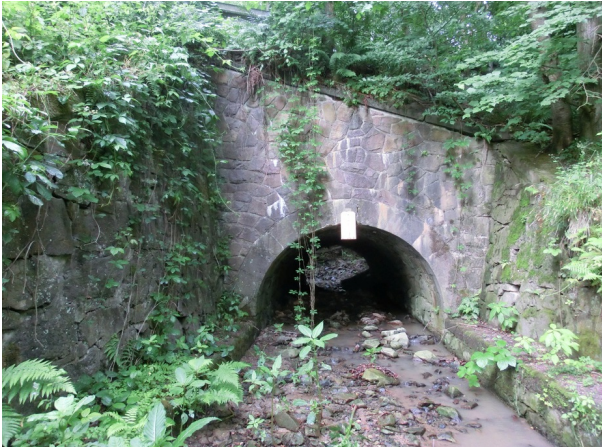
Abbildung 17: Natursteinbrücke westlich Bauwerk 10
