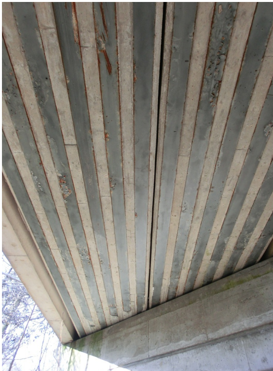
Abbildung 28: Bauwerk 16, Querfuge mit Hangplätzen
