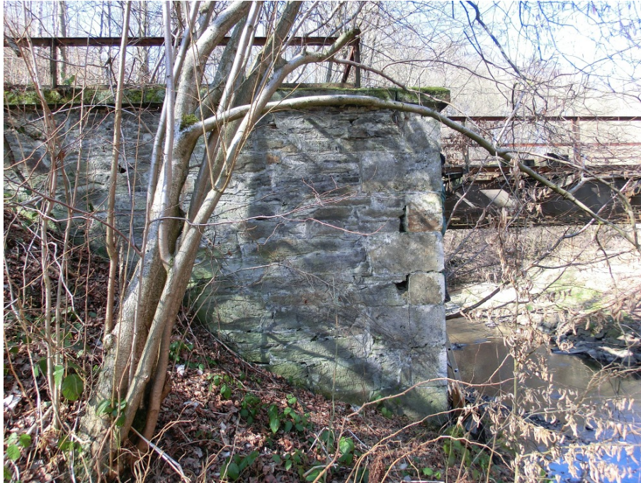
Abbildung 5: Bauwerk 4, Stahlbrücke über Kleine Striegis
