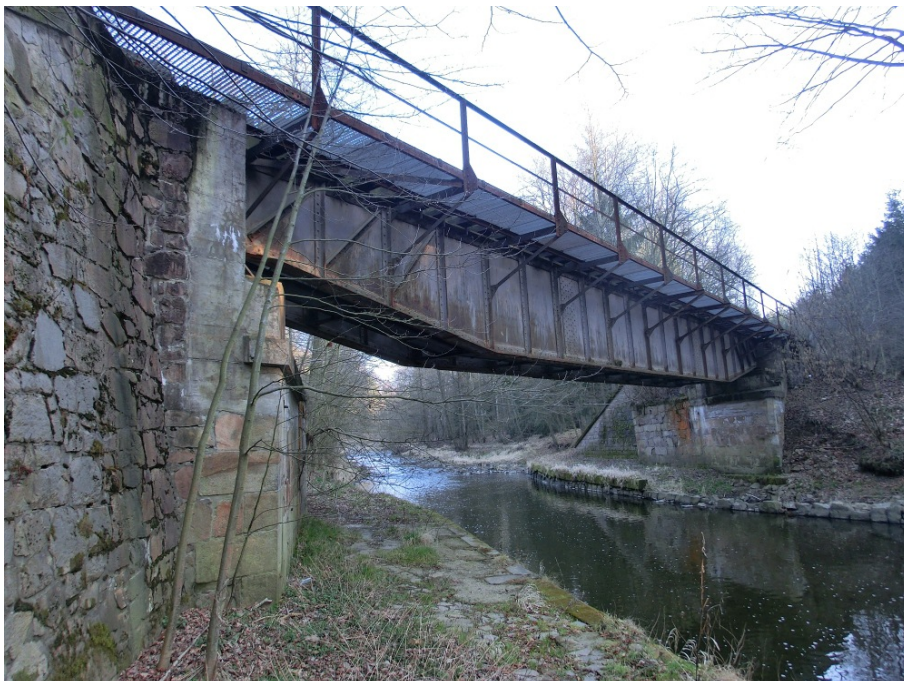
Abbildung 12: Bauwerk 9, Stahlbrücke über Striegis
