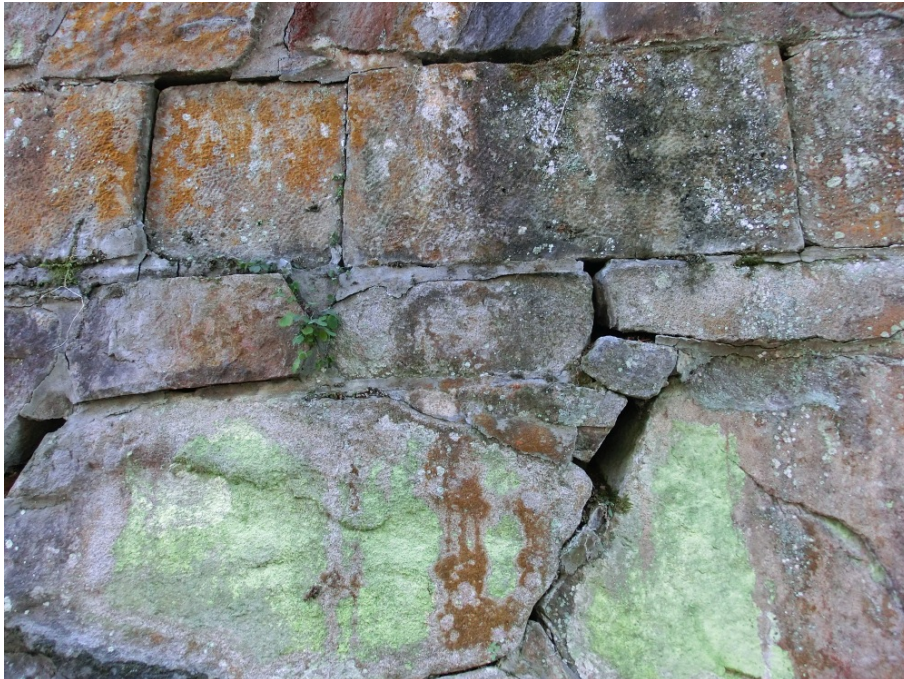
Abbildung 11: Bauwerk 8, Fugen in der Stützmauer
