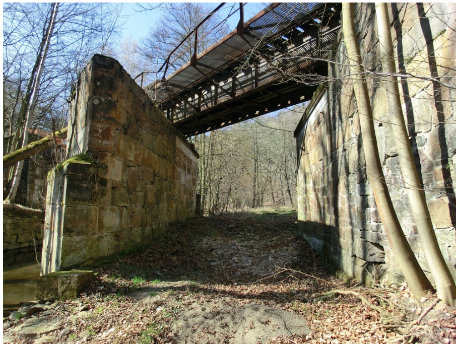
Abbildung 6: Bauwerk 5, Zweifeld-Stahlbrücke über Kleine Striegis
