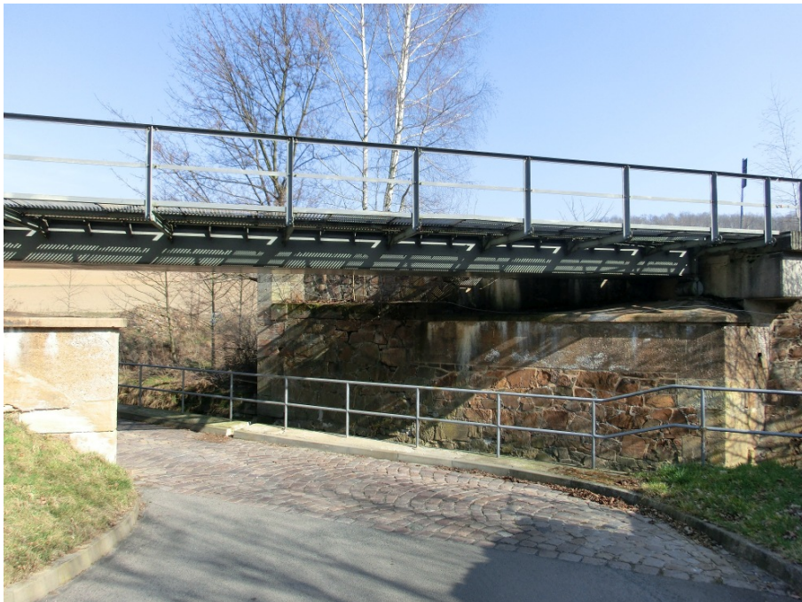
Abbildung 24: Bauwerk 14, Stahlbrücke über Weg und Graben
