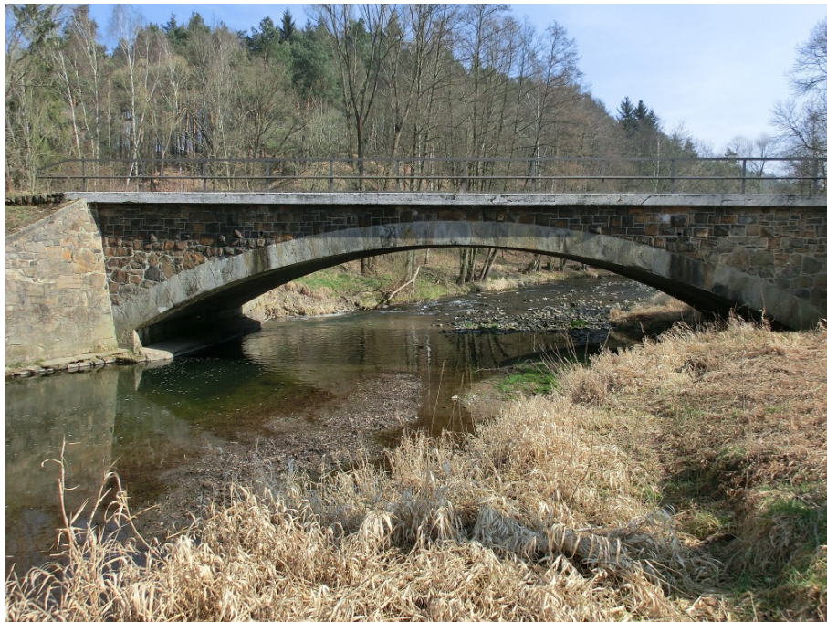
Abbildung 19: Bauwerk 11, Gewölbebrücke über Striegis
