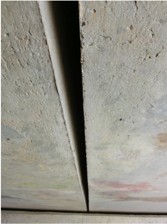
Abbildung 15: Bauwerk 10, Querfuge mit Hangplätzen
