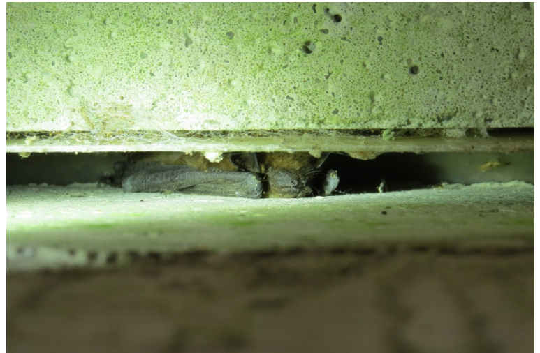
Abbildung 16: Bauwerk 10, Abendsegler im Winterquartier
