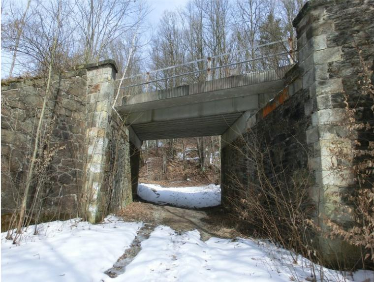
*Abbildung 5: Bauwerk 3, Beton-Walzträger-Brücke*
