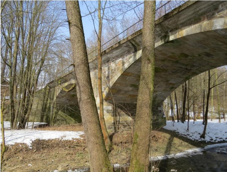
*Abbildung 3: Bauwerk 2, Zweifeld-Gewölbebrücke*
