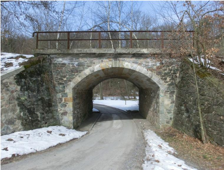
*Abbildung 11: Bauwerk 6, Einfeldgewölbebrücke*
