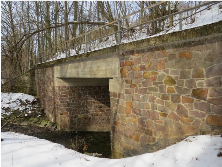
*Abbildung 9: Bauwerk 5, Stahlbetonplatten-Brücke*
