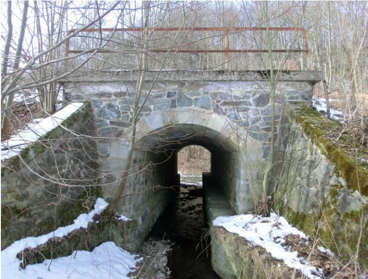
*Abbildung 13: Bauwerk 7, Gewölbebrücke*
