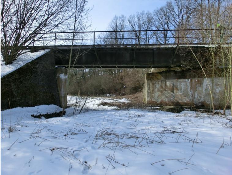
*Abbildung 17: Bauwerk 10, Stahlträgerbrücke über Flutgelände*
