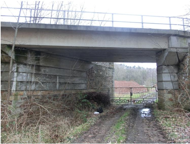
Abbildung 7: Bauwerk 19, Stahlbetonbrücke über einen Weg
