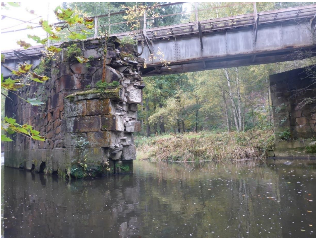
Foto 89: Zu sanierender Mittelpfeiler am BW 12
