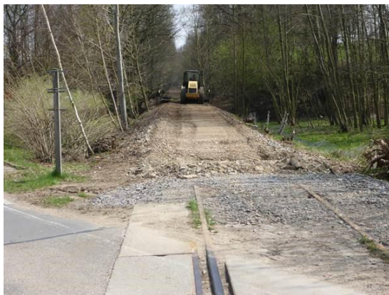
Foto 20: Über-Kopf-Bauweise eines Radweges (Chemnitztalradweg)
