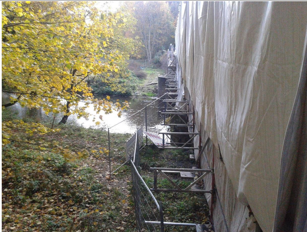
Foto 76: Beispiel für Einhausung während der Sanierungsarbeiten am Bauwerk
