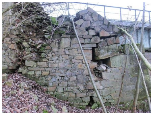
Foto 95: Spalten und Hohlräume in der stark verbrochenen Stützmauer des BW 21 als potenzielles Quartier (SCHMIDT 2016)
