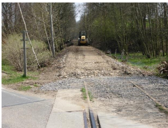
Foto 17: Beispiel für Vor-Kopf-Bauweise bei der Nachnutzung von Bahntrassen als Radwege
