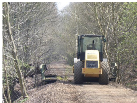
Foto 18: Erhalt der randlichen Gehölze durch Vor-Kopf-Bauweise
