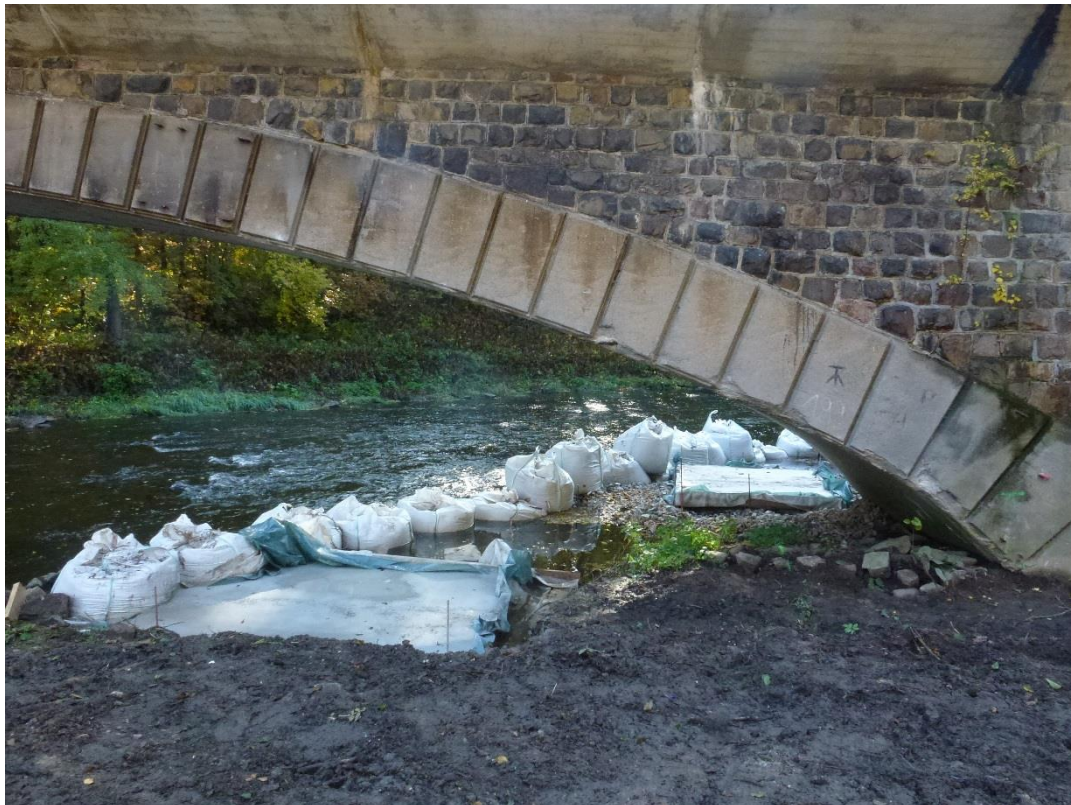
Foto 75: Beispiel Fangedamm während der Bauzeit. Fließgewässerdurchgängigkeit bleibt vollständig erhalten. Randliche temporäre Eingriffe in Uferbereich
