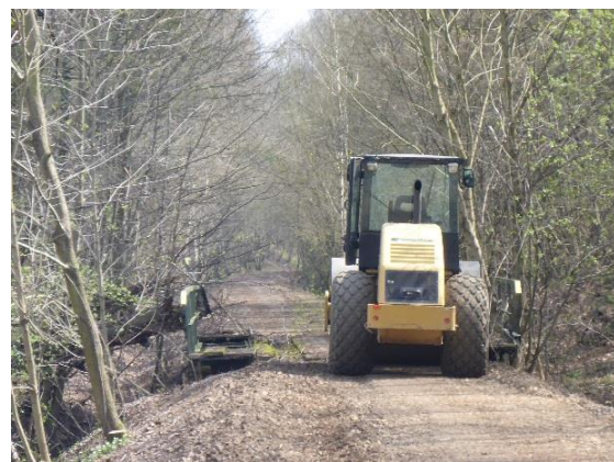
Foto 1: Beispiel für Vor-Kopf-Bauweise bei der Nachnutzung von Bahntrassen als Radwege
