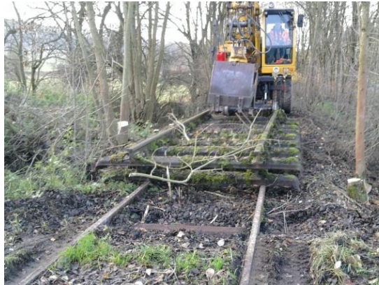
Foto 95: Entfernung von Gleise und Schwellen (Foto: http://forum.bauforum24.biz/forum/index.php?showtopic=44442 )
