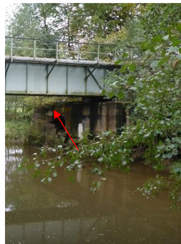
Foto 61: Zu sanierende Flügelmauer BW 21
