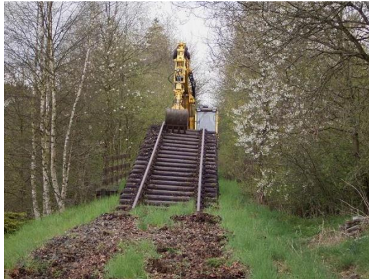
Foto 96: Entfernung von Gleisen und Schwellen (Foto: KERPEN 2015)
