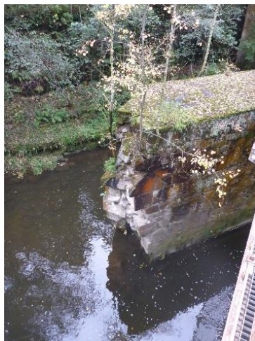
Foto 59: Zu sanierender Mittelpfeiler von BW 12
