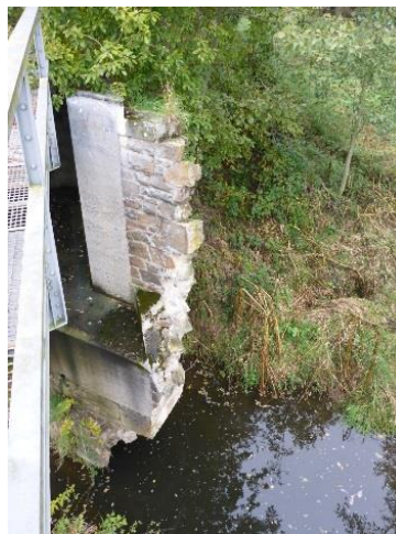
Foto 60: Zu sanierende Flügelmauer BW 19
