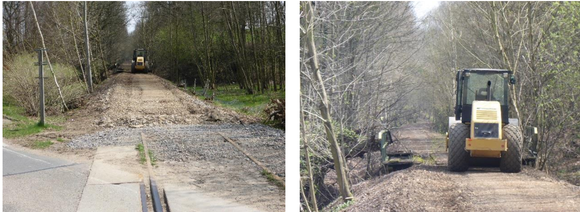
Foto 46: Beispiel für Vor-Kopf-Bauweise bei der Nachnutzung von Bahntrassen als Radwege
