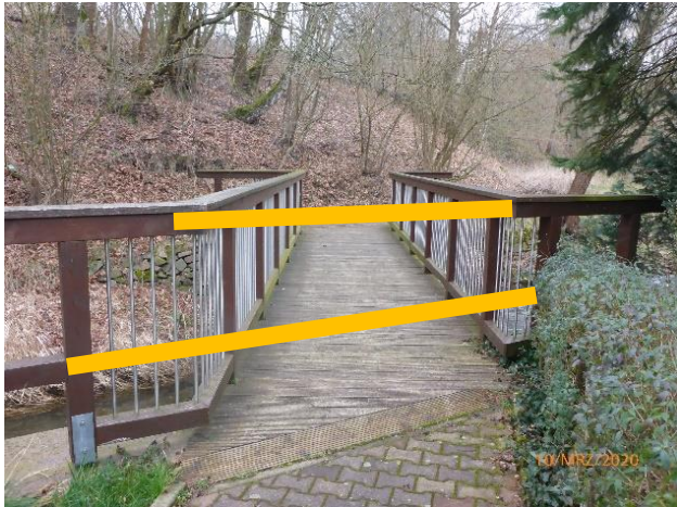
Foto 11: Rückbau der Fußgängerbrücke über die Kleine Striegis und anschließende Ufersicherung (orange)
