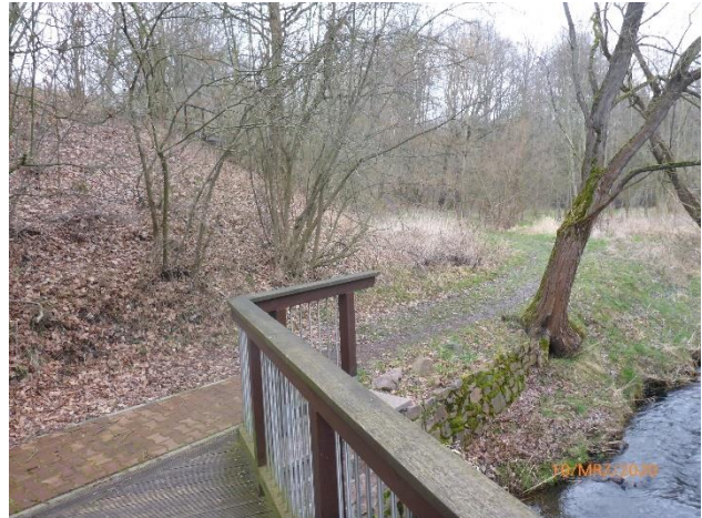
Foto 12: Rückbau der Wegebefestigungen am nördlichen Ufer der Kleinen Striegis
