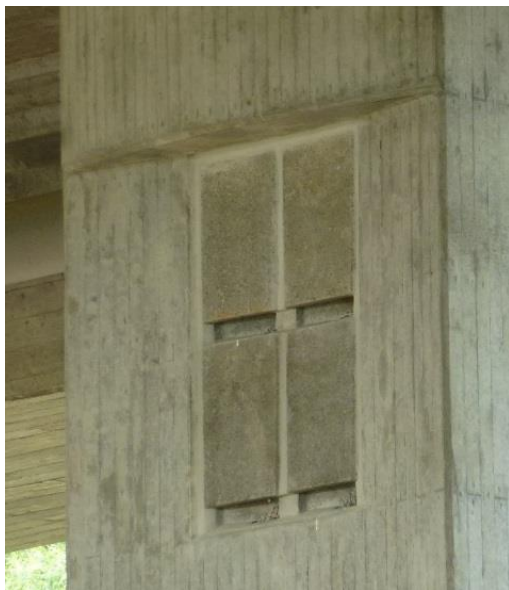
Foto 3: Ganzjahres-Einbauquartiere im Bereich eines Brückenpfeilers
