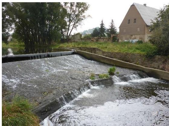
Foto 17: Wehranlage Grunau mit parallel geführter Fischaufstiegsanlage
