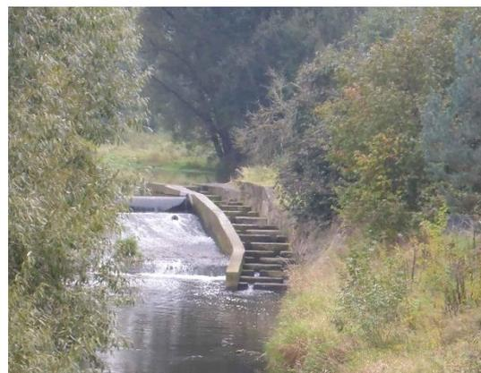
Foto 18: Fischaufstiegsanlage parallel der Wehranlage Grunau
