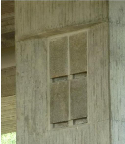
Foto 80: Ganzjahres-Einbauquartiere im Bereich eines Brückenpfeilers
