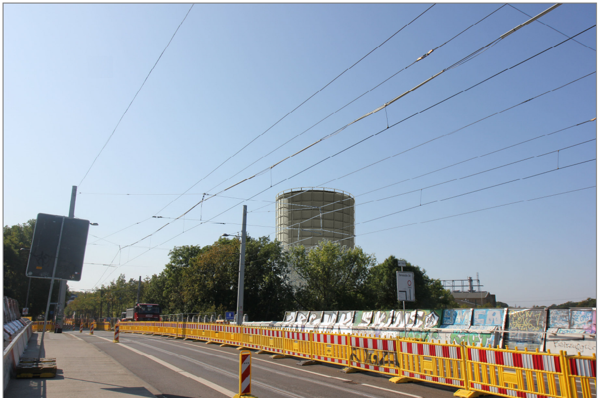
Abbildung 28: Visualisierung der neuen Baukörper des HKW Süd, Blickpunkt Brücke Bornaische Straße nach Südwest
